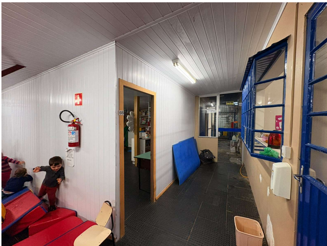
Imagem 10 – Foto da atual sala de recreação, onde será executada a ampliação
