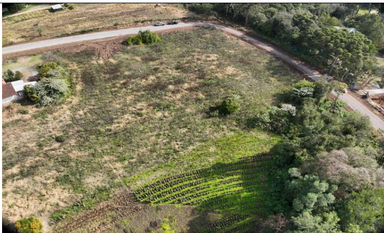
Imagem 02 – Vista aérea do local – Rua Florindo Chesini e Rua Silva Jardim
