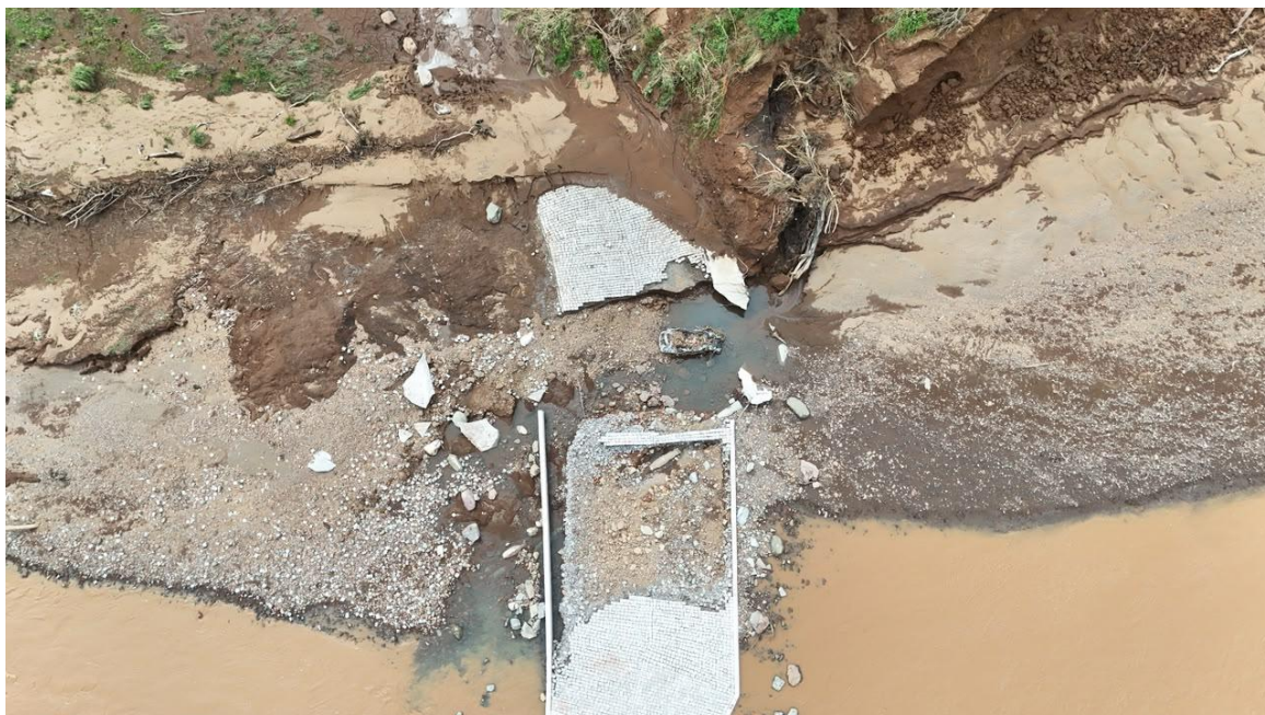
Figura 13 - Dano completo à cabeceira no lado de Cotiporã
