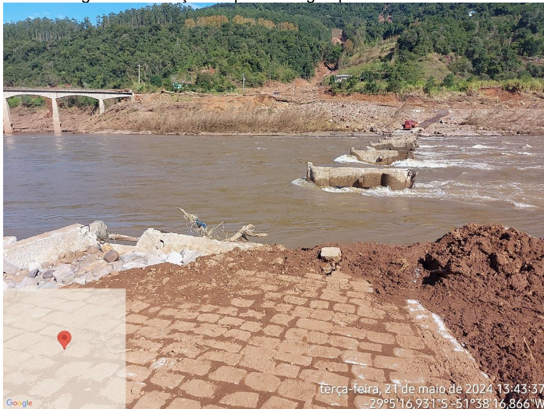
Figura 3 - Situação da ponte antiga após as enchentes de 2024
