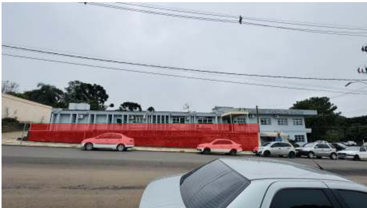
Figura 02: Foto geral da fachada frontal, demarcando à área de intervenção.
