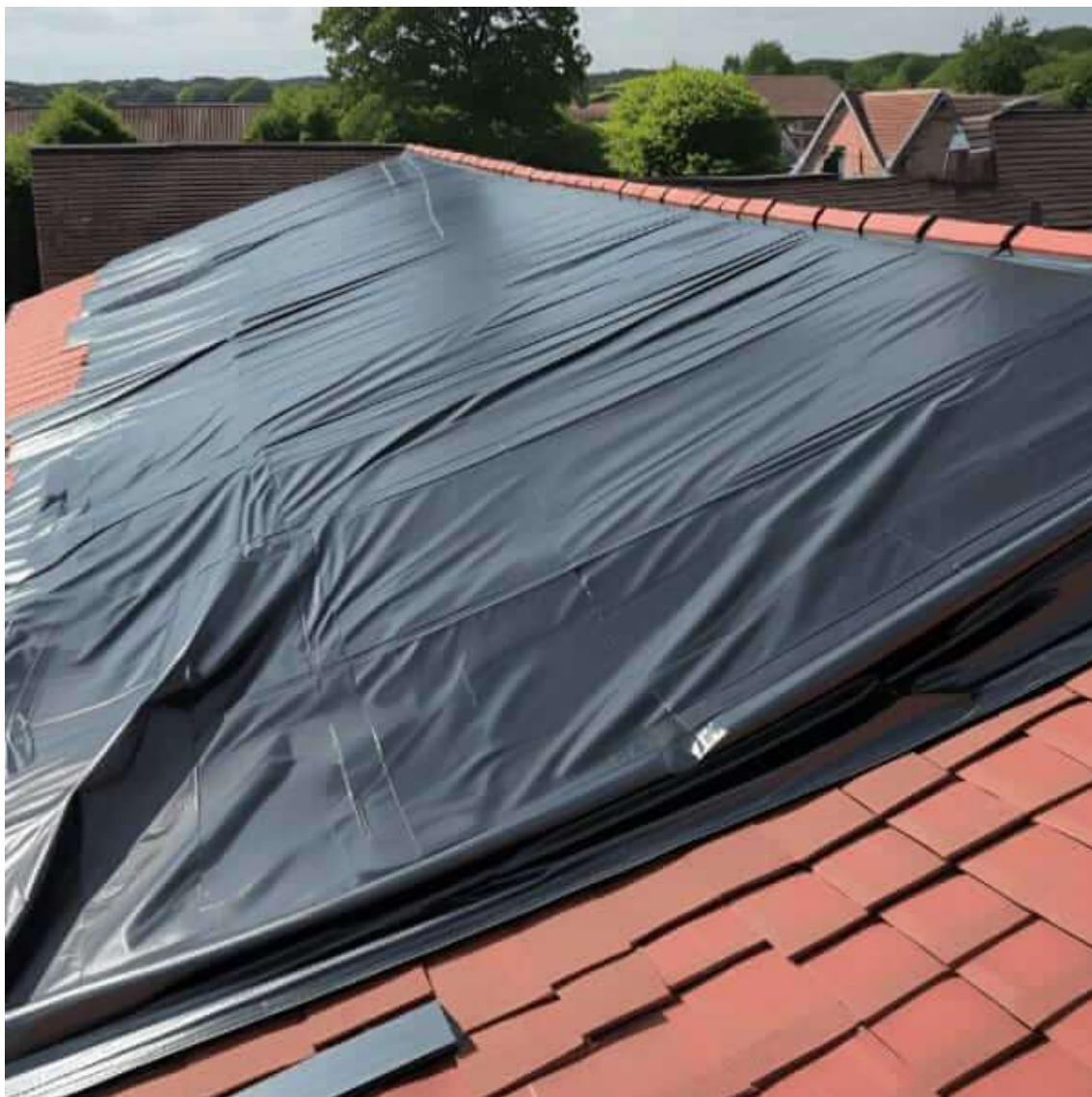
Imagem – Proteção da cobertura com loneamento
