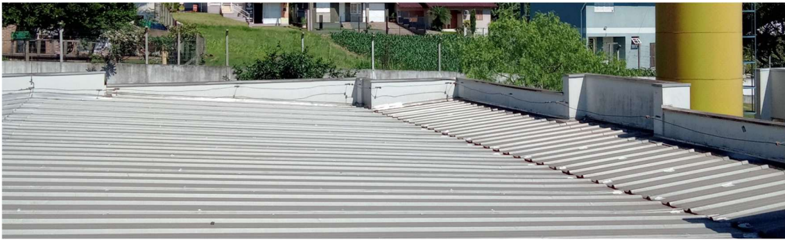
Imagem – Remoção de capeamento, SPDA (com reaproveitamento) e algerozas.
