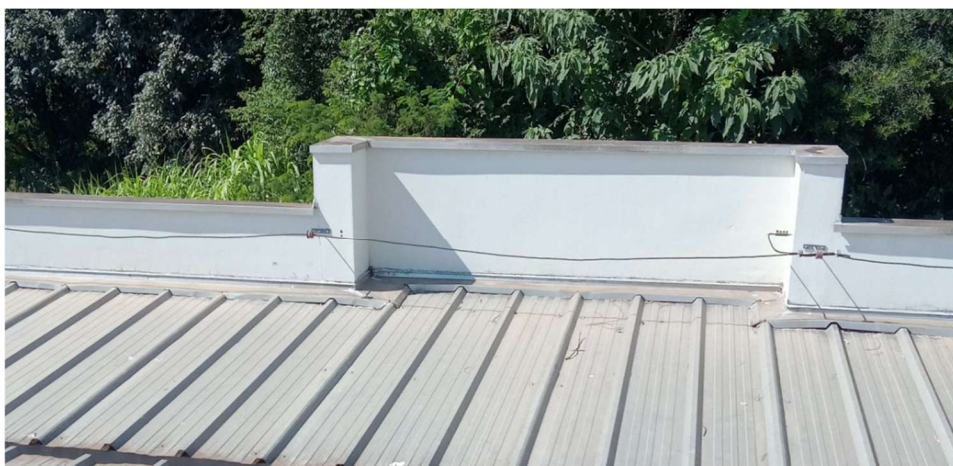
Imagem – Remoção de capeamento, SPDA (com reaproveitamento) e algerozas.
