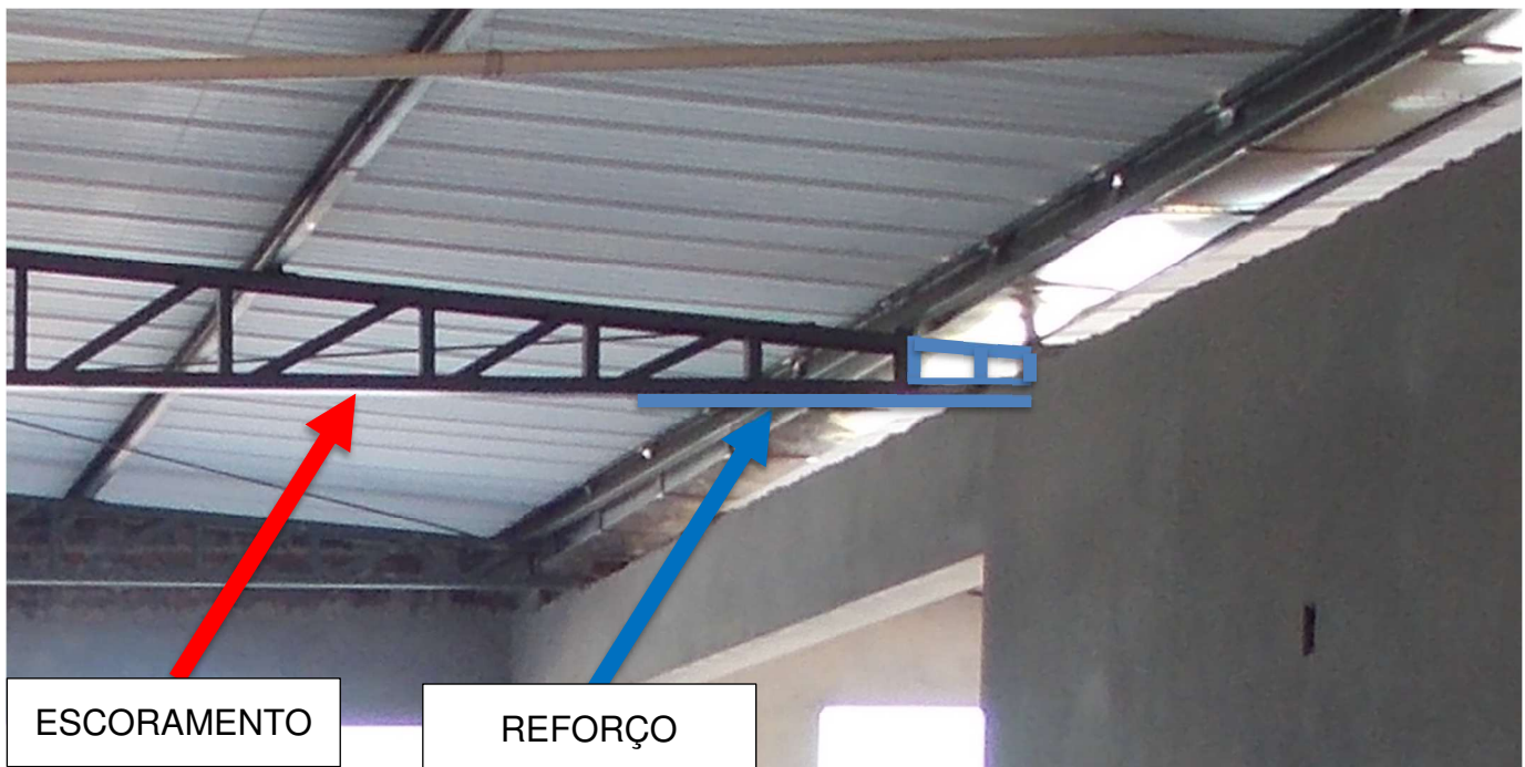
Imagem – Detalhe de reforço das treliças existentes
