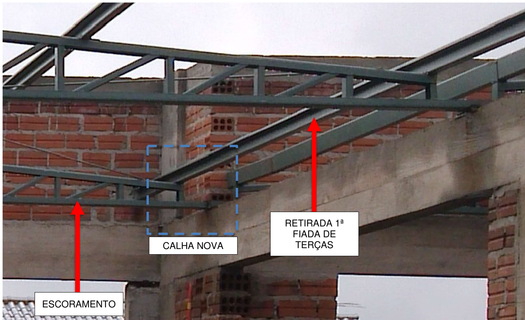
Imagem – Detalhe de instalação nos cantos limites
