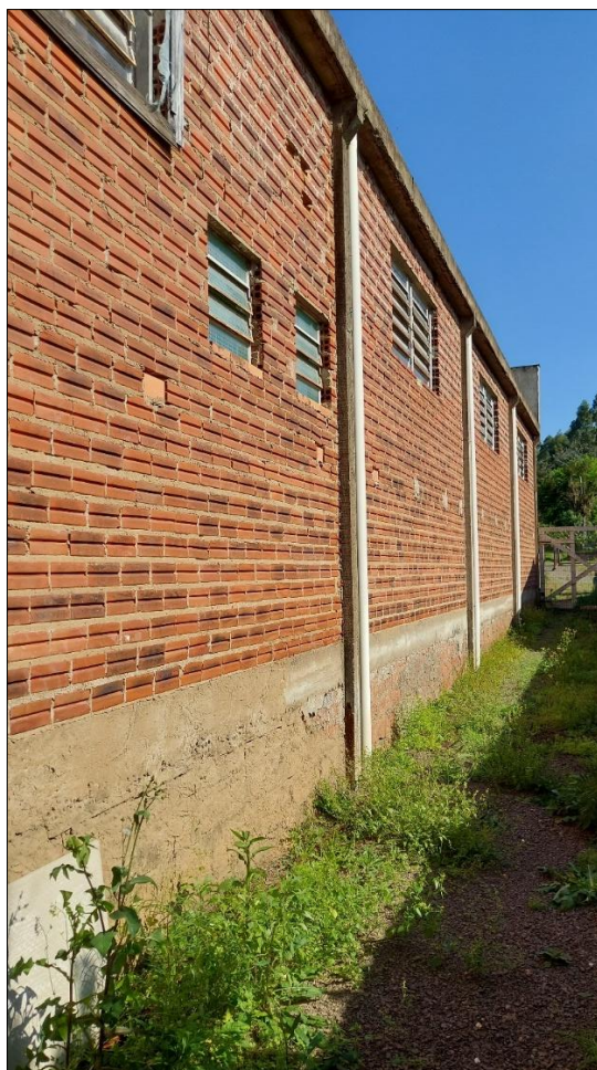
Paredes externas que receberão revestimento argamassado e pintura
