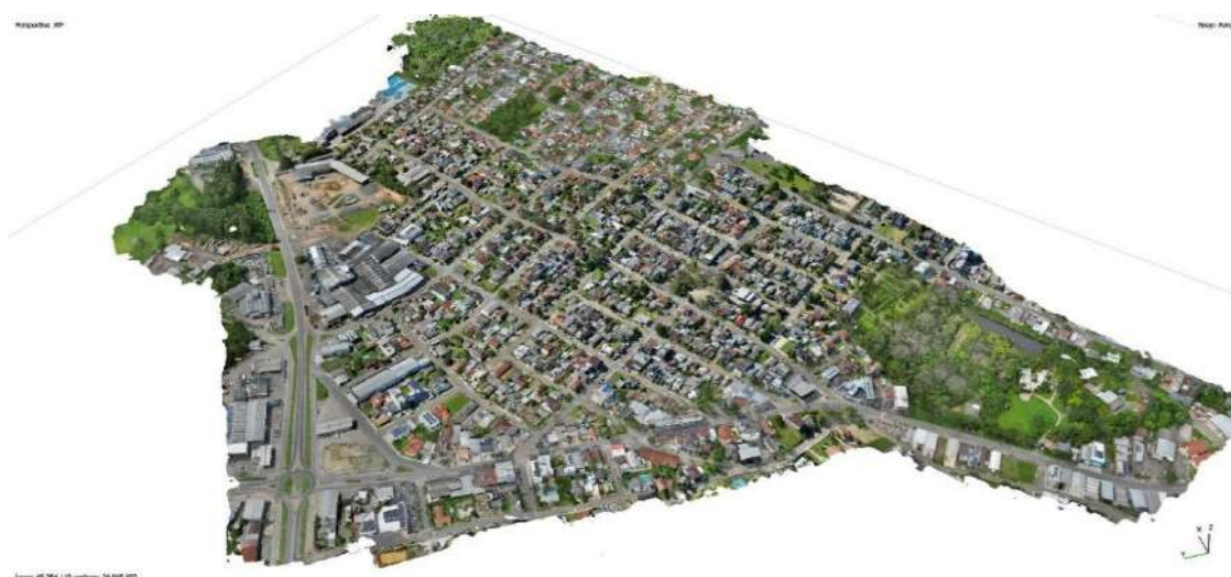
Figura 1- Vista do Bairro São João e Seus Arredores no arquivo 3D gerados a partir da utilização de Drones.
