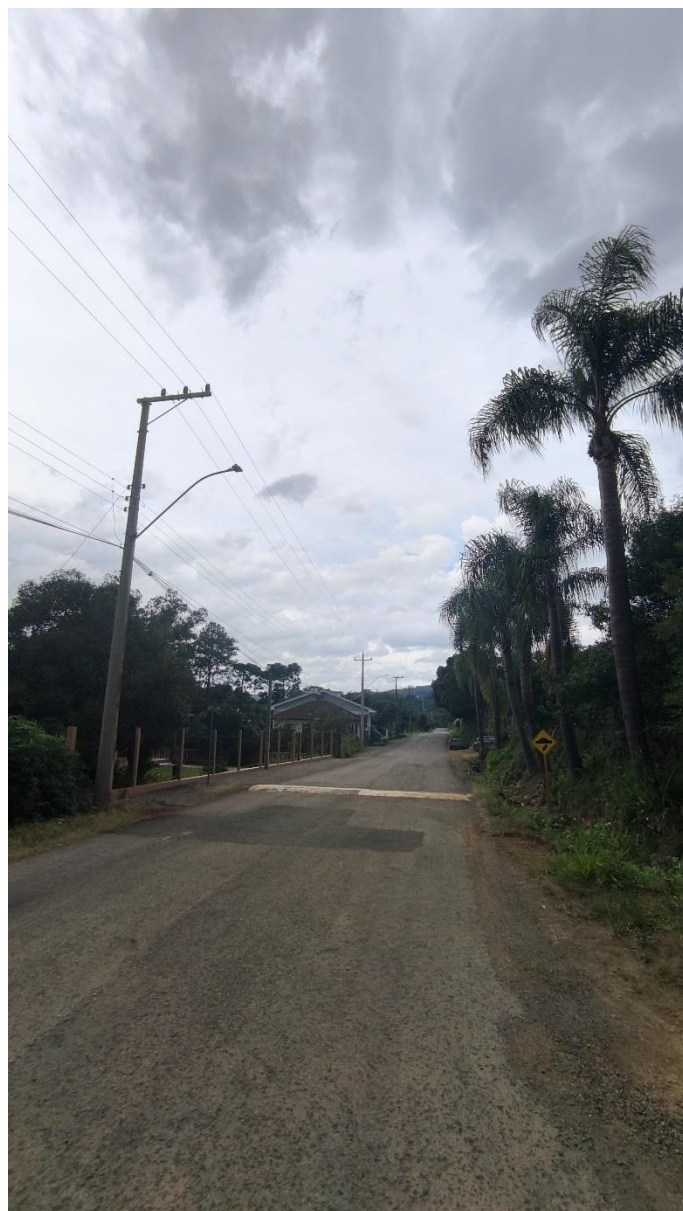
Figura 11 - Rede elétrica em frente ao local do poço.
