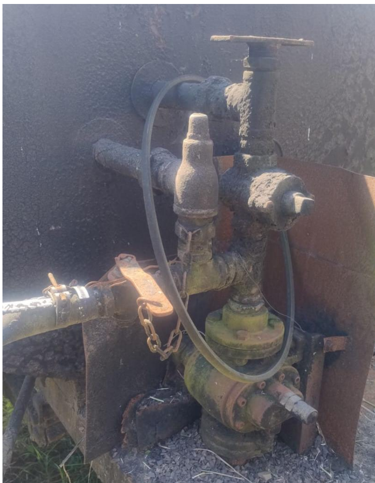
Lote 26 - USINA DE ASFALTO - 5
