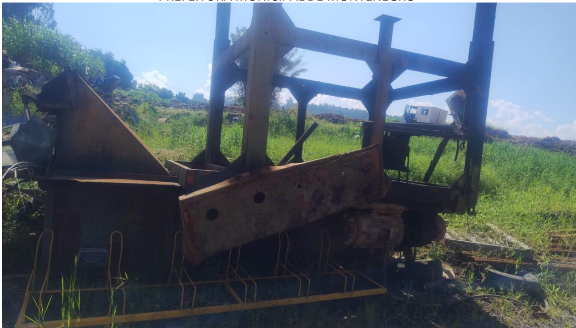
Lote 26 - USINA DE ASFALTO - 4
