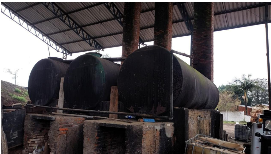
Lote 26 - USINA DE ASFALTO - 3
