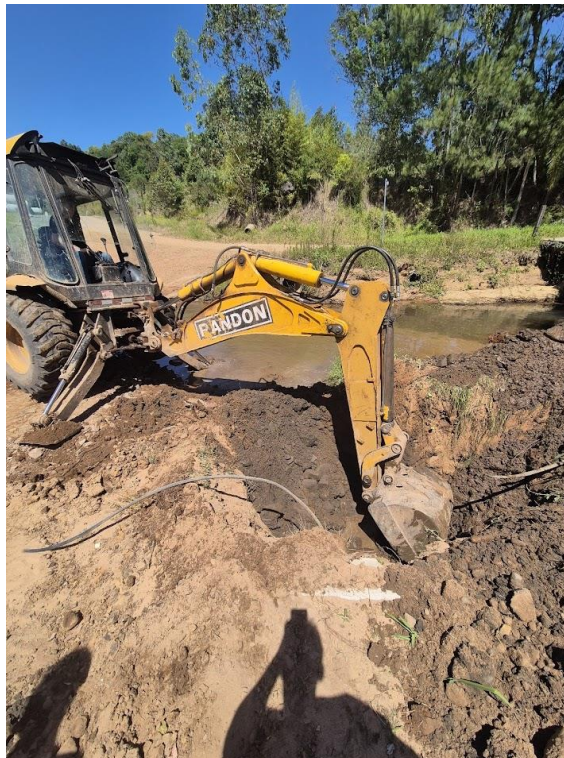
Figura 46 - Execução de vala de reconhecimento do solo
