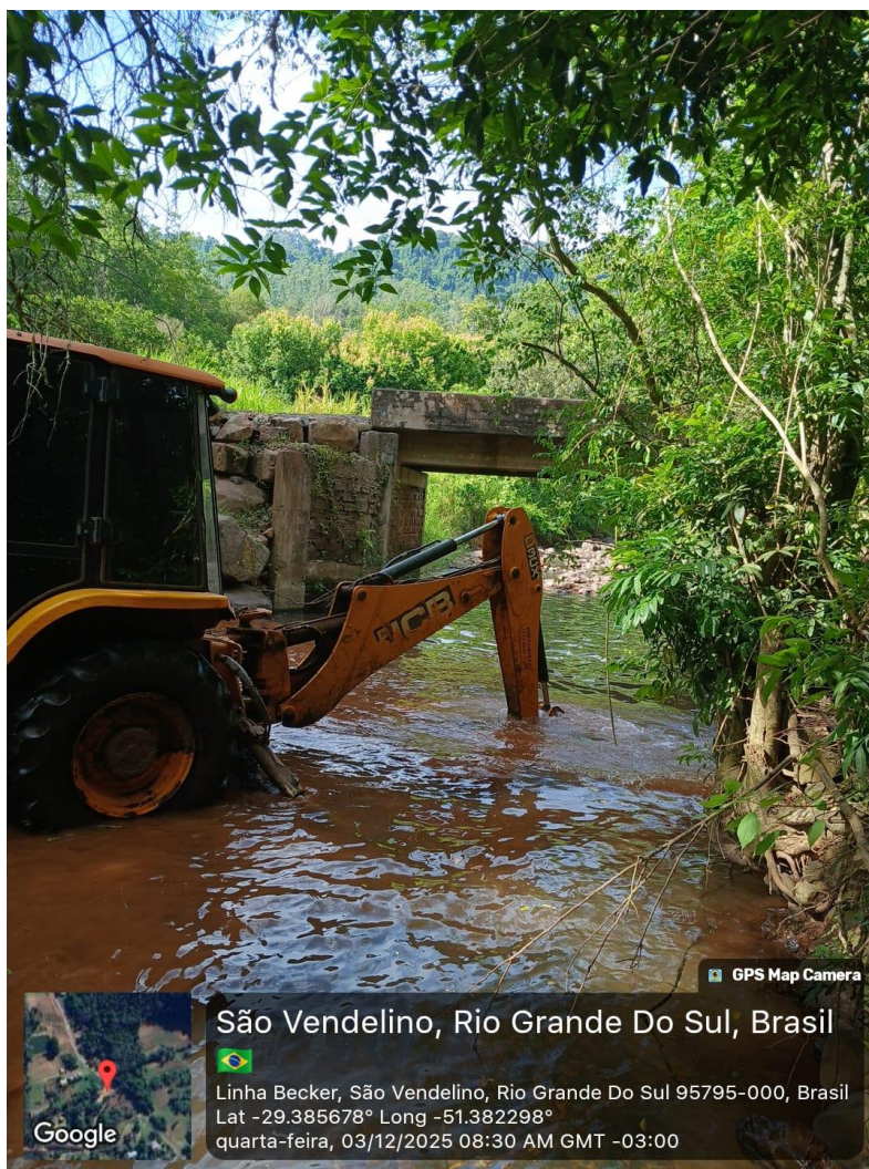
Fotografia 02 – Execução da sondagem no local da implantação da OAE, utilizando-se retroescavadeira para abertura de vala de inspeção.
