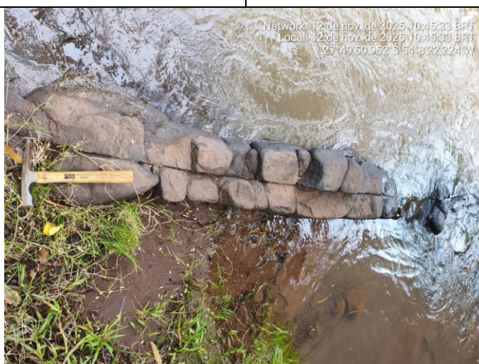
Img. 3. Afloramento de rocha na base da estrutura.
