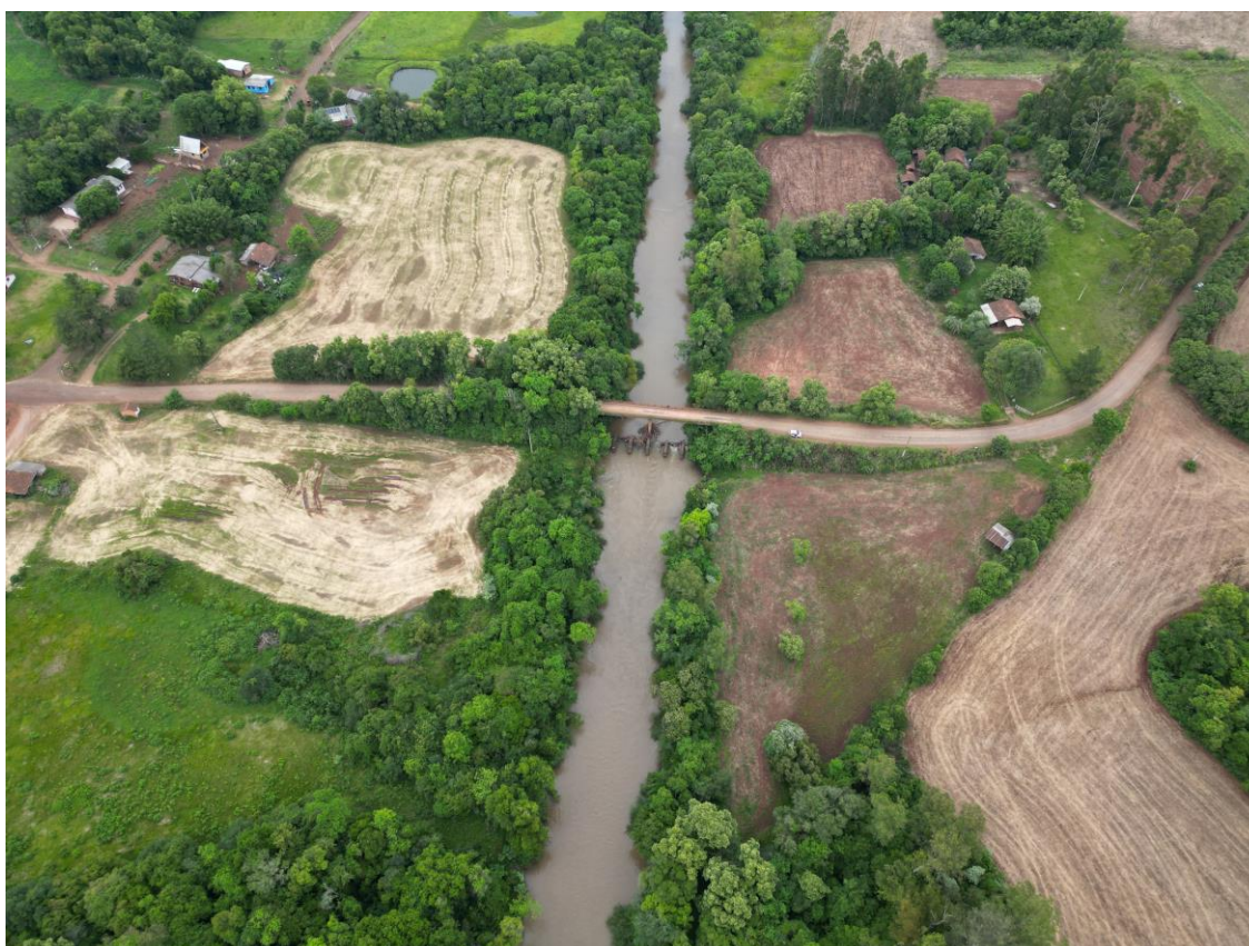
Img. 10. Visão lateral da ponte já existente e do Rio Buricá.
