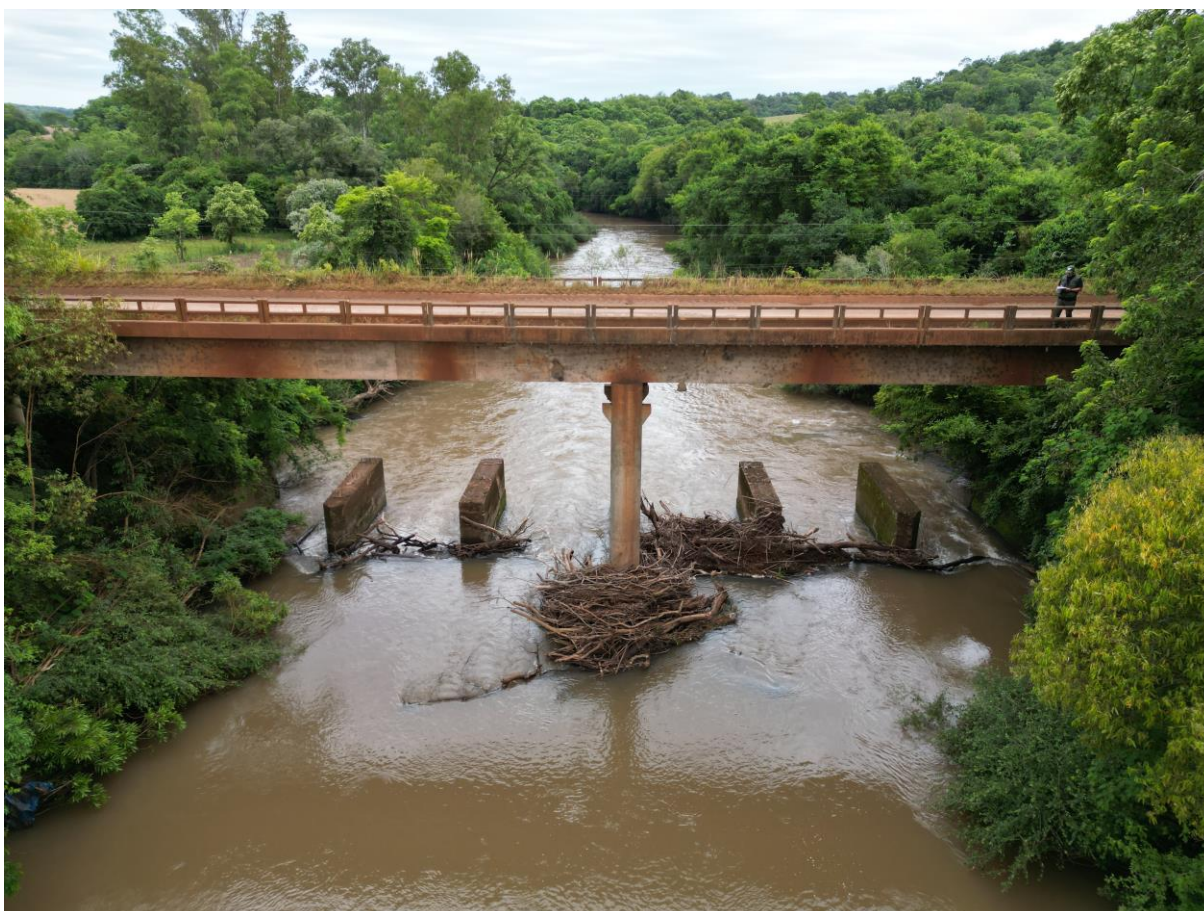
Img. 8. Vista da ponte existente.
