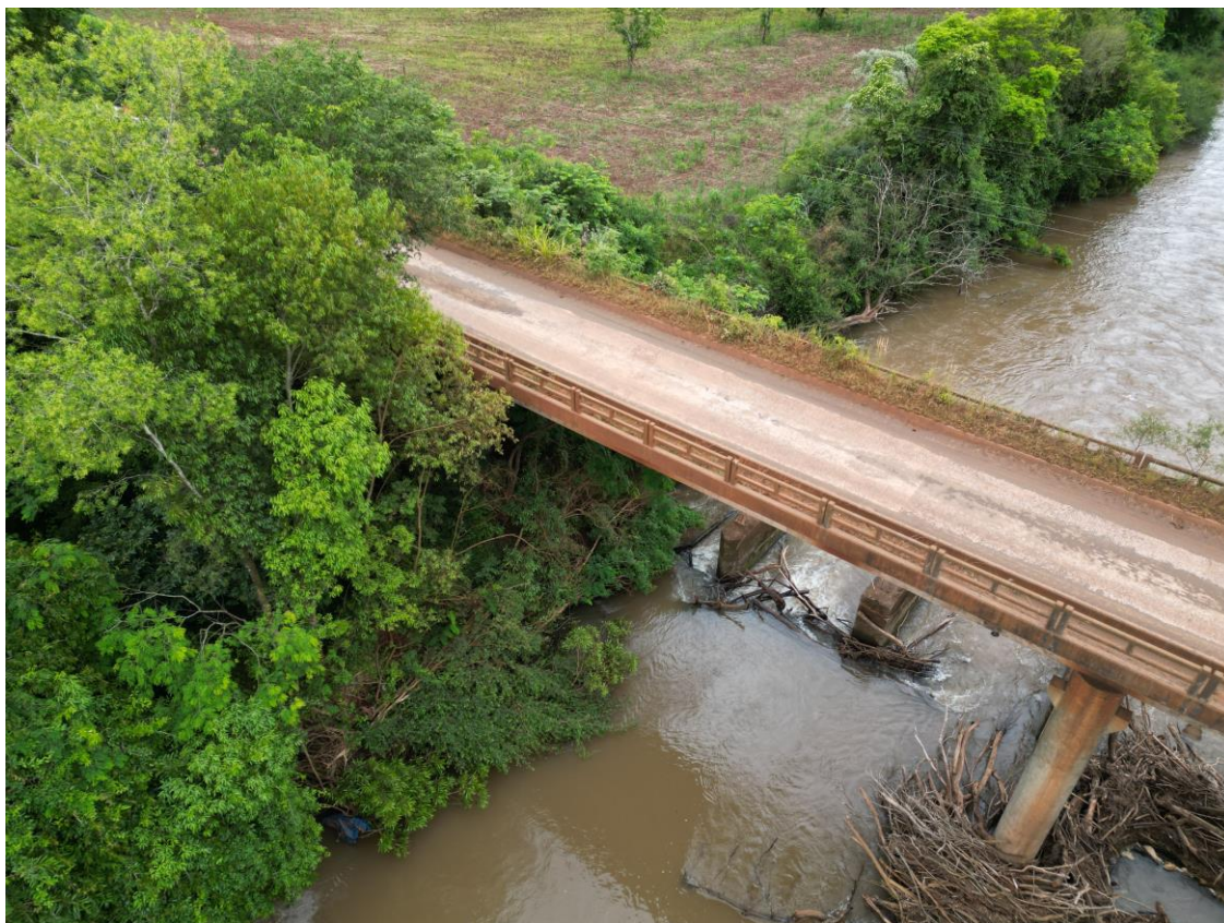
Img. 9. Visão do talude formado pela geração da cabeceira.
