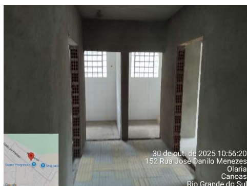
13. circulação bloco administrativo ao fundo sanitário
