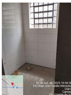
14. Vista interna dos sanitários administrativos
