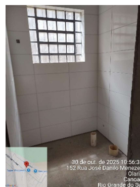
15. Vista interna dos sanitários administrativos
