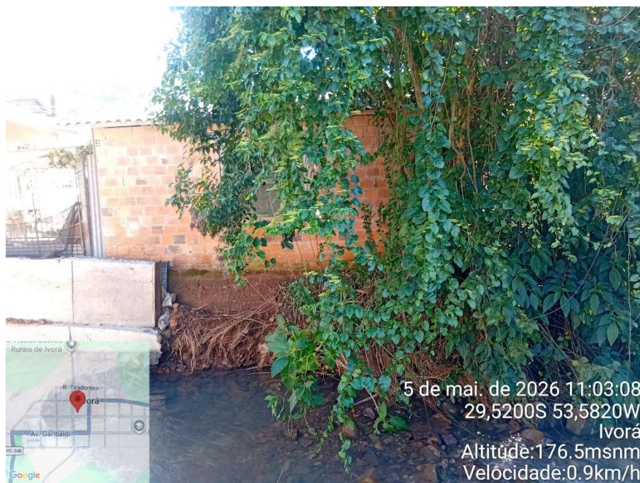
Imagem 6 – local para construção do Radier
