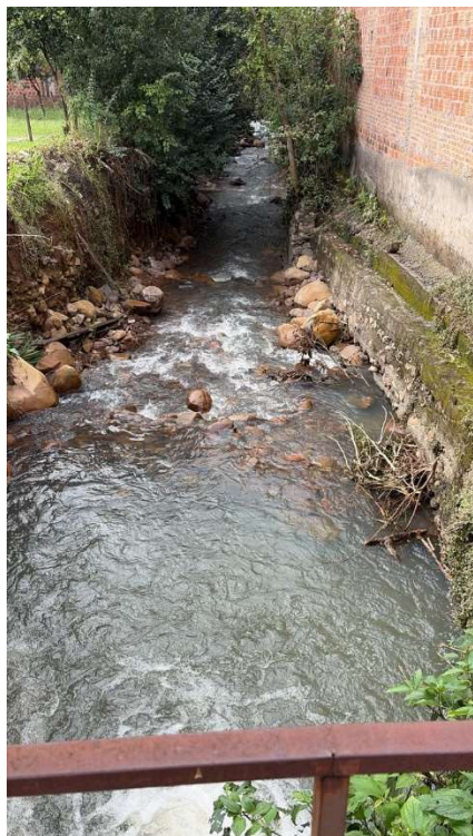
Imagem 1 – local para construção do radier
