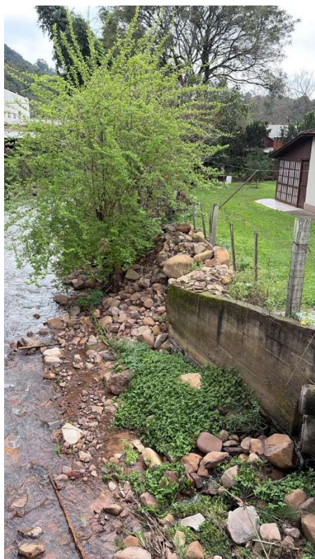
Imagem 4- local para construção de muro de contenção
