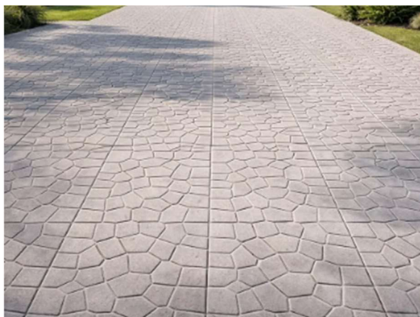
Figura 6 – Piso em placas de concreto
