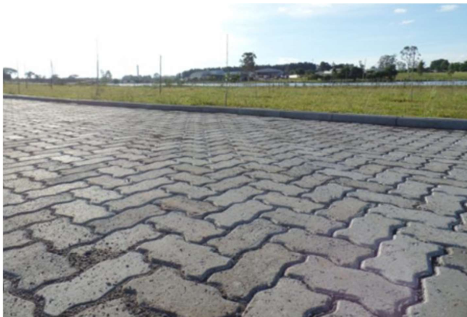
Figura 4 - Piso intertravado disposto em espinha de peixe
