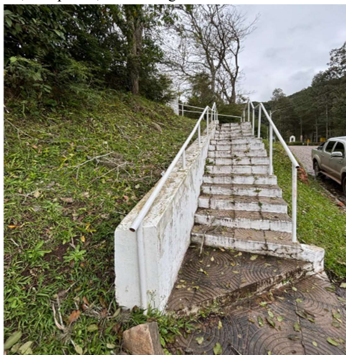
Figura 5 – Escada de acesso principal
