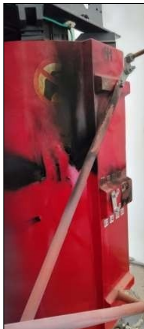
Foto 1: Transformador avariado
