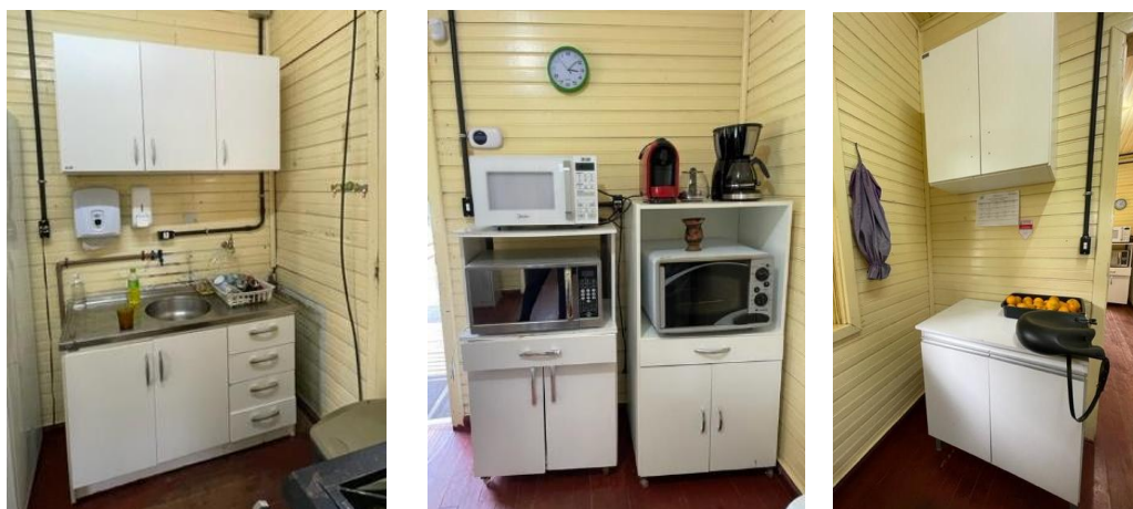
Imagens 22,23 e 24: Armários da antiga cozinha que serão reaproveitados
