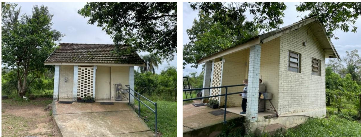
Imagens 03 e 04: Estrutura dos sanitários existentes no local
