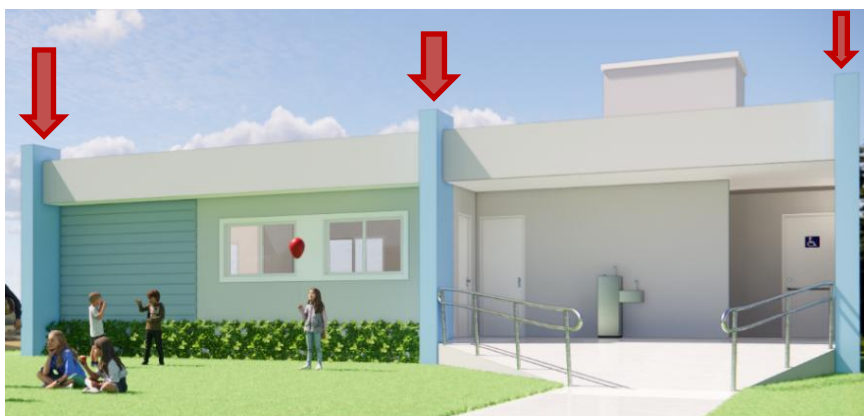
Imagem 26: localização dos pilares evidentes na fachada principal
