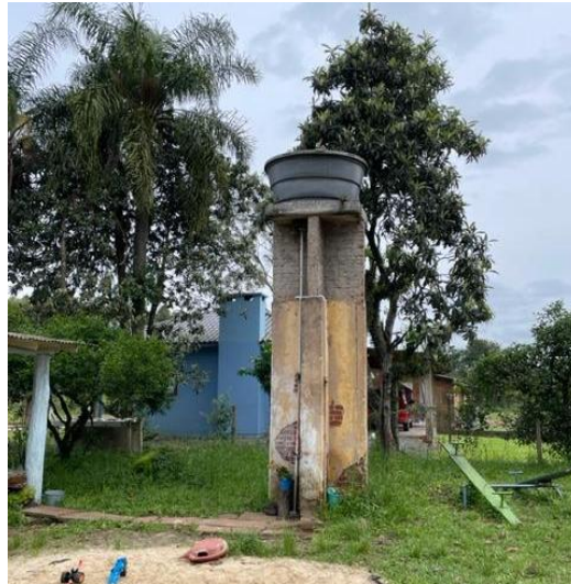
Imagem 05: Estrutura existente para a caixa d'água
