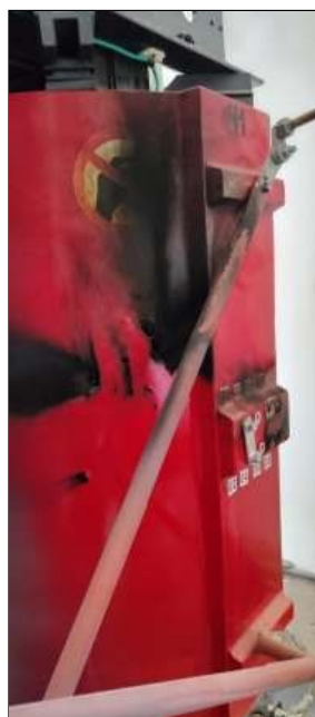
Foto 1: Transformador avariado Foto 2: Transformador avariado
