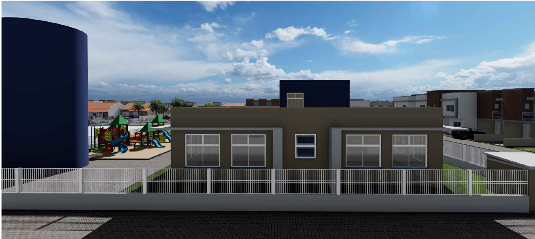
FACHADA LATERAL – RUA LUIZINHO
