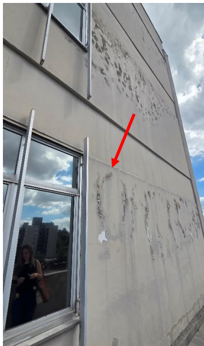
Manchas de mofo junto às esquadrias, na parte interna do prédio
