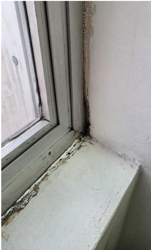
Manchas de mofo junto às esquadrias, na parte interna do prédio
