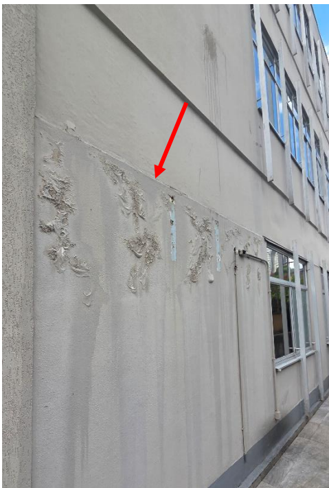
Manchas de mofo junto às esquadrias, na parte interna do prédio
