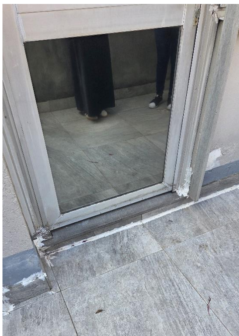
Porta sem rodo veda porta (acesso à varanda do 3º pavimento)
