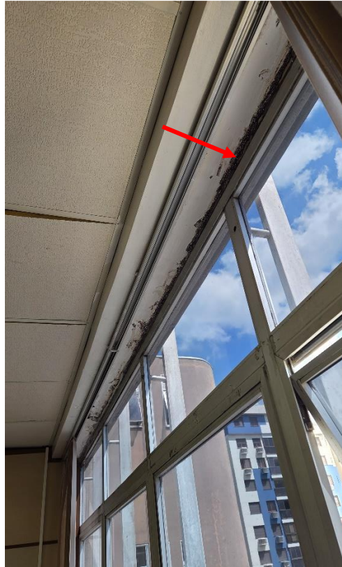
Manchas de mofo junto às esquadrias, na parte interna do prédio
