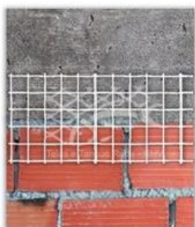
Junção da alvenaria com as vigas
