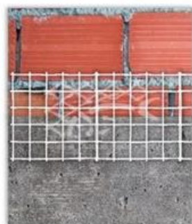
Junção da laje com a alvenaria de platibanda
