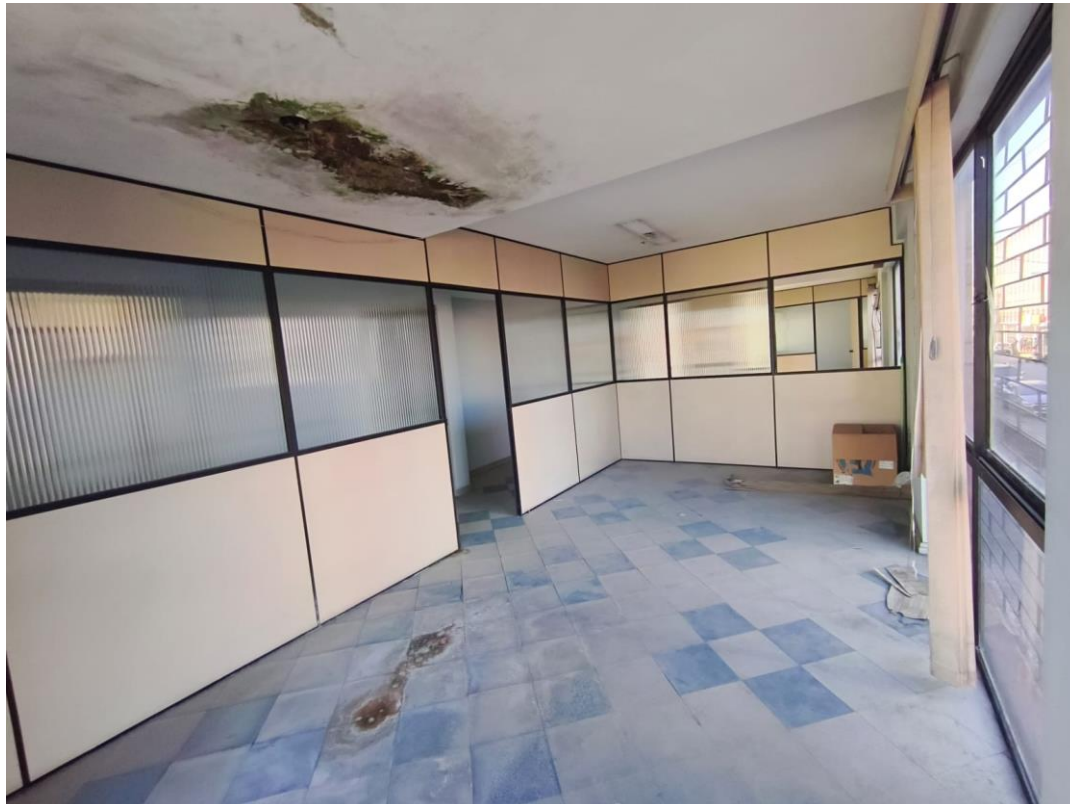
Foto 14: Sala interna Fonte: Carvalho Lira Engenharia, 2026
