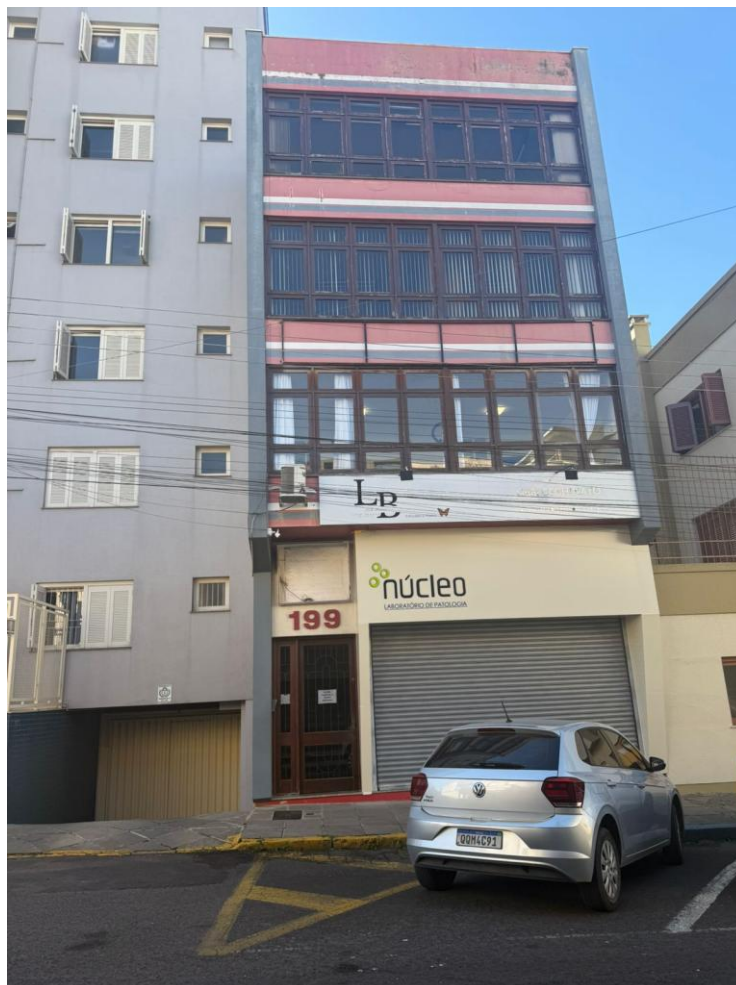
Foto 1: Fachada frontal do imóvel Fonte: Carvalho Lira Engenharia, 2026
