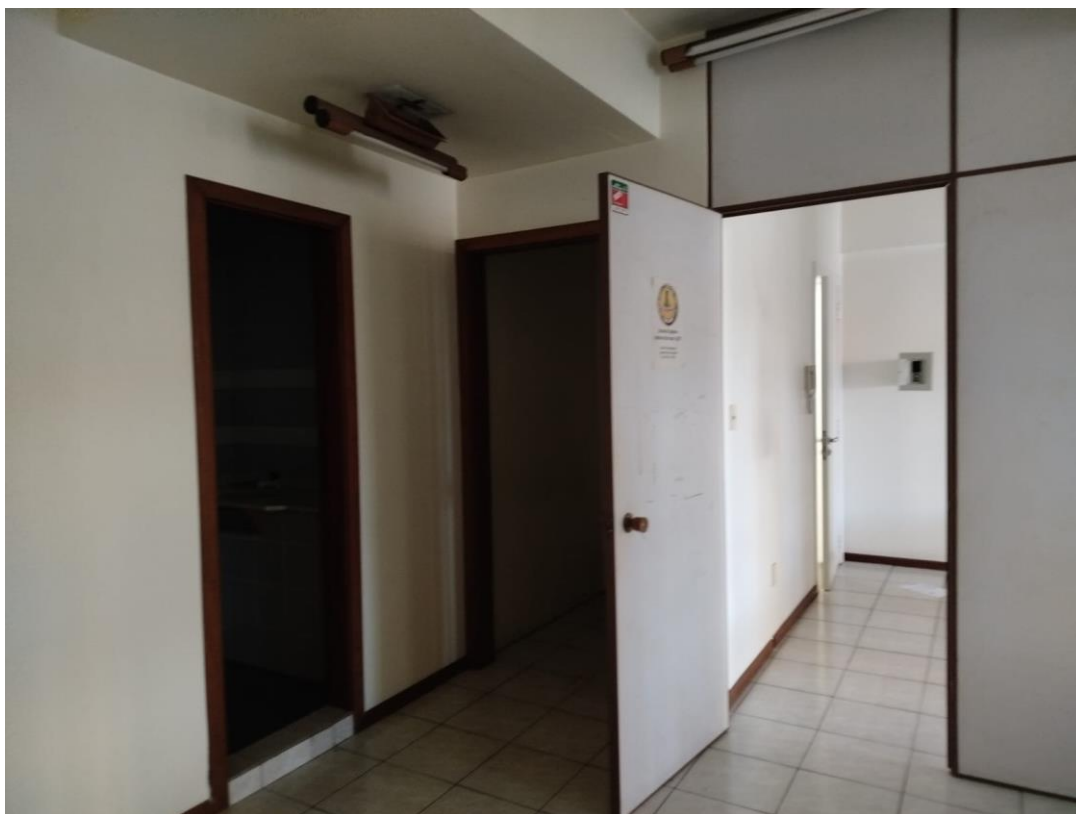
Foto 10: Sala interna Fonte: Carvalho Lira Engenharia, 2026
