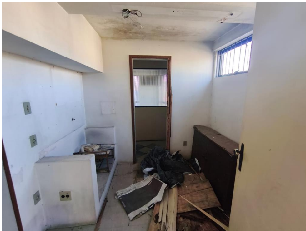
Foto 13: sala 201 - interna Fonte: Carvalho Lira Engenharia, 2026
