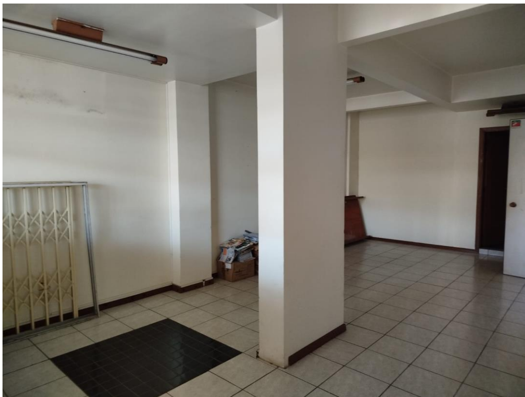
Foto 7: Sala interna Fonte: Carvalho Lira Engenharia, 2026
