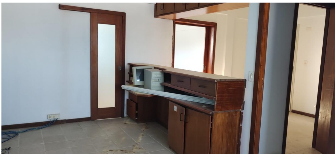
Foto 4: Sala interna Fonte: Carvalho Lira Engenharia, 2026
