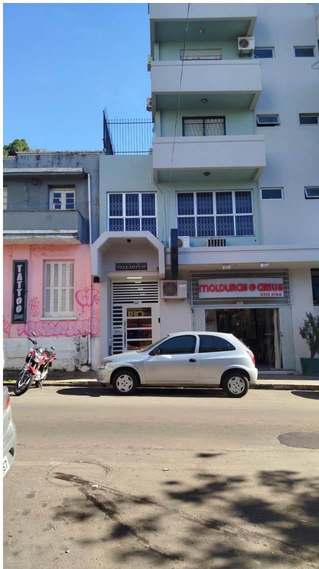
Foto 1: Fachada frontal do imóvel Fonte: Carvalho Lira Engenharia, 2026
