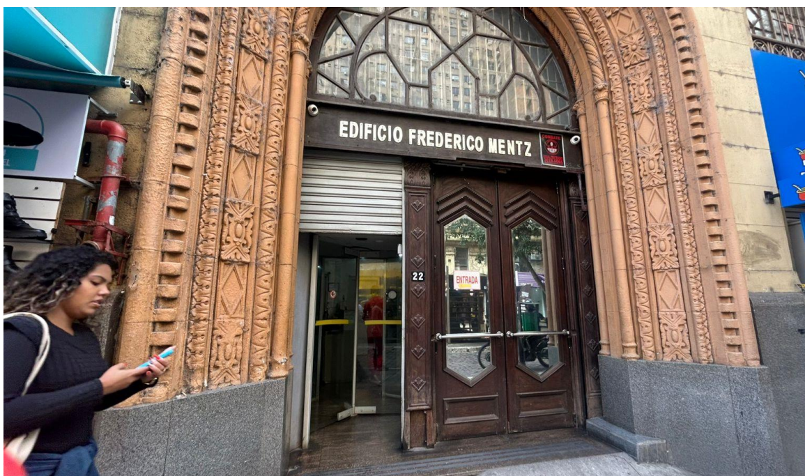
Foto 2: Entrada Fonte: Carvalho Lira Engenharia, 2026
