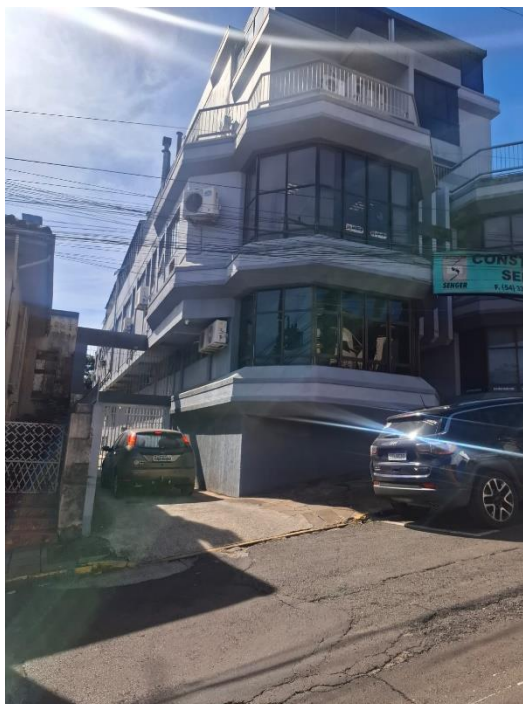
Foto 2: Fachada frontal do imóvel Fonte: Carvalho Lira Engenharia, 2026
