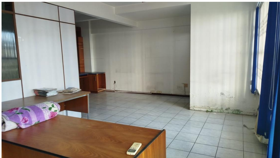
Foto 9: Sala interna Fonte: Carvalho Lira Engenharia, 2026
