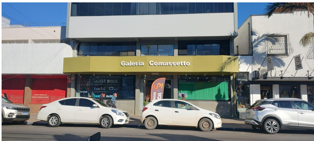
Foto 1: Fachada frontal do imóvel Fonte: Carvalho Lira Engenharia, 2026
