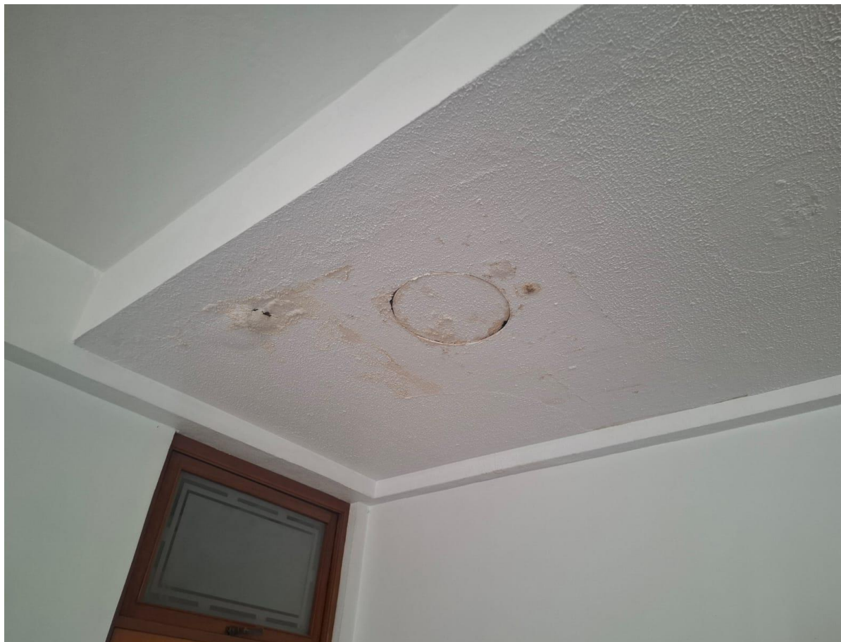
Foto 16: Detalhe – teto sala interna Fonte: Carvalho Lira Engenharia, 2026
