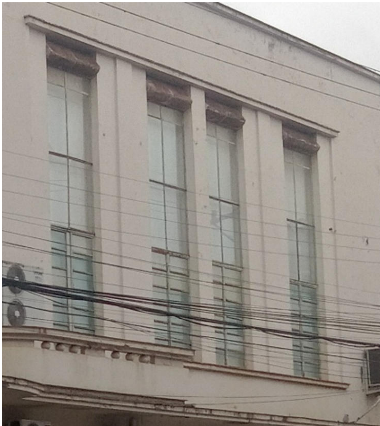
PINTURA ESQUADRIAS, INCLUSIVE CAIXAS METÁLICAS
