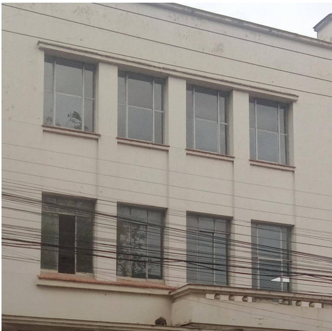
LIXAMENTO E PINTURA DAS ESQUADRIAS
