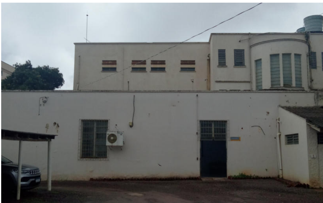
FACHADA OESTE - TAMPONAMENTO DE BURACOS, LIXAMENTO DE ESQUADRIAS E PINTURA
