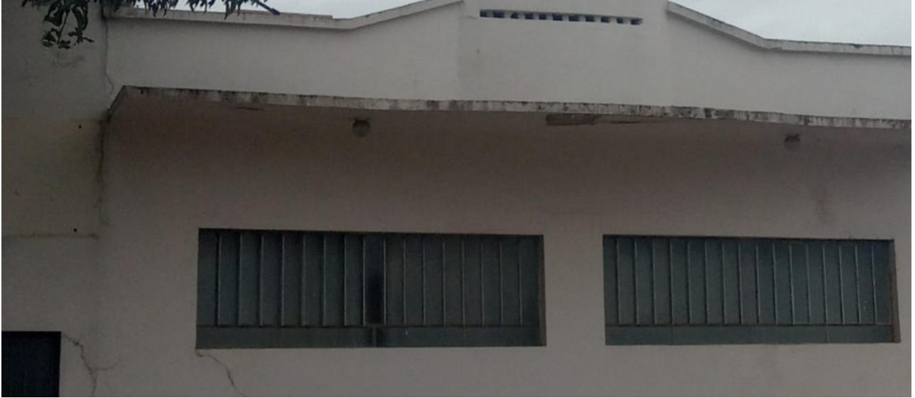
EMASSAMENTO, LIXAMENTO E PINTURA
