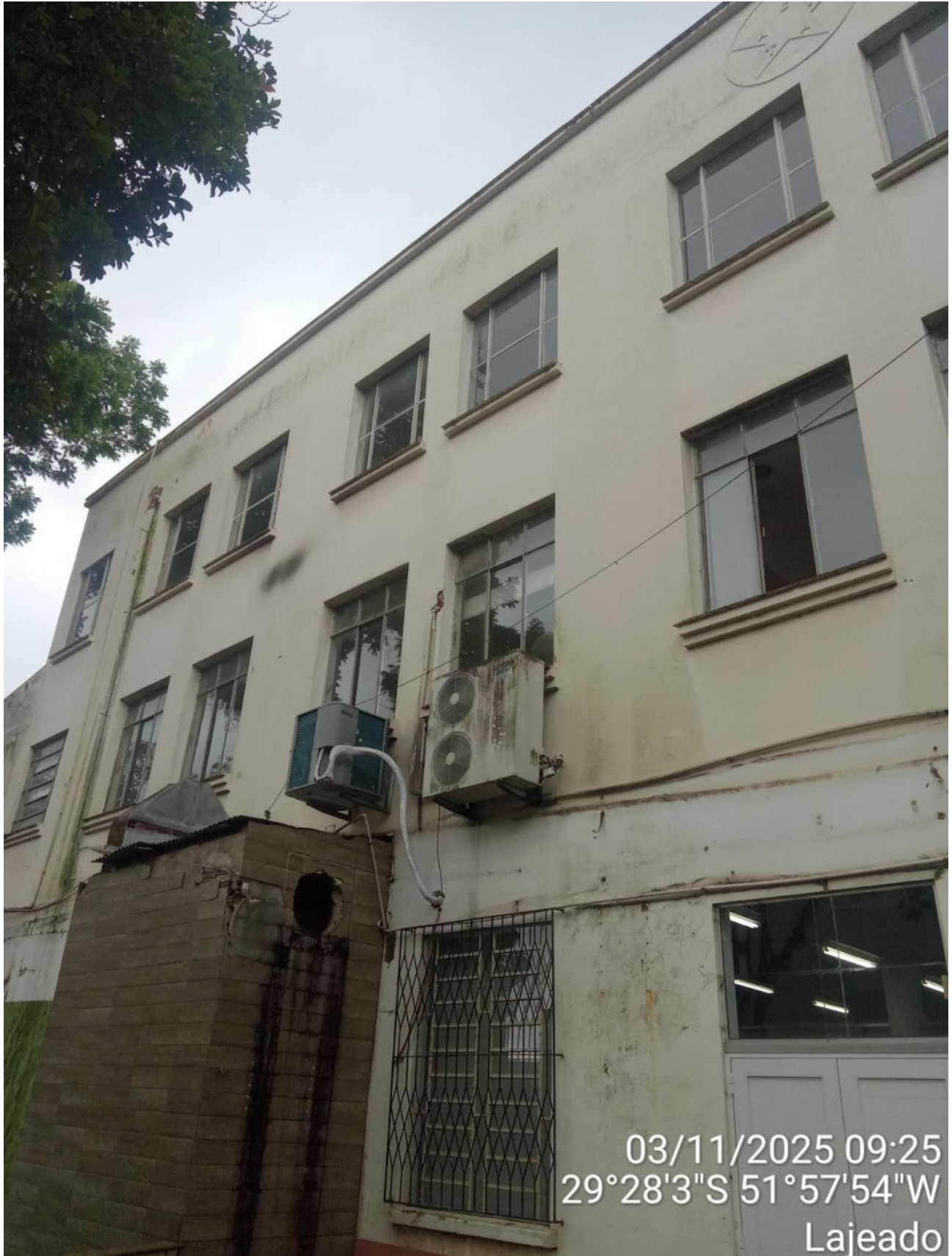
FACHADA SUL: LIXAMENTO E PINTURA DE ESQUADRIAS
