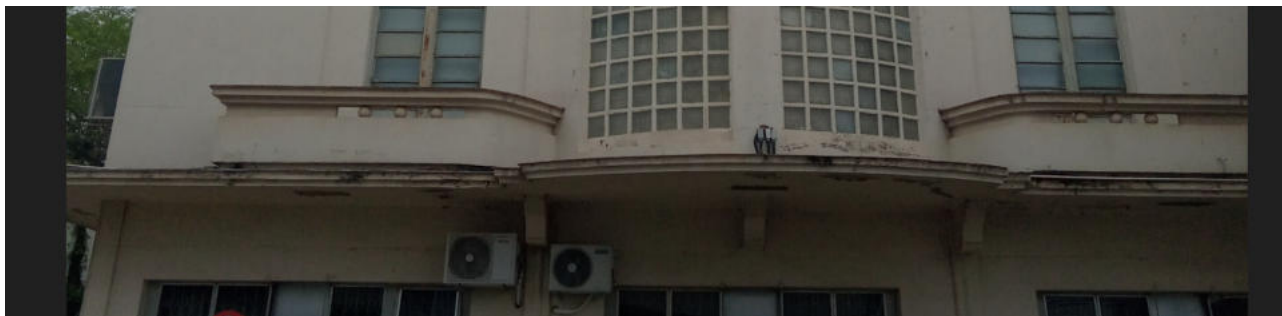
ARGAMASSA POLIMÉRICA NA MARQUISE
