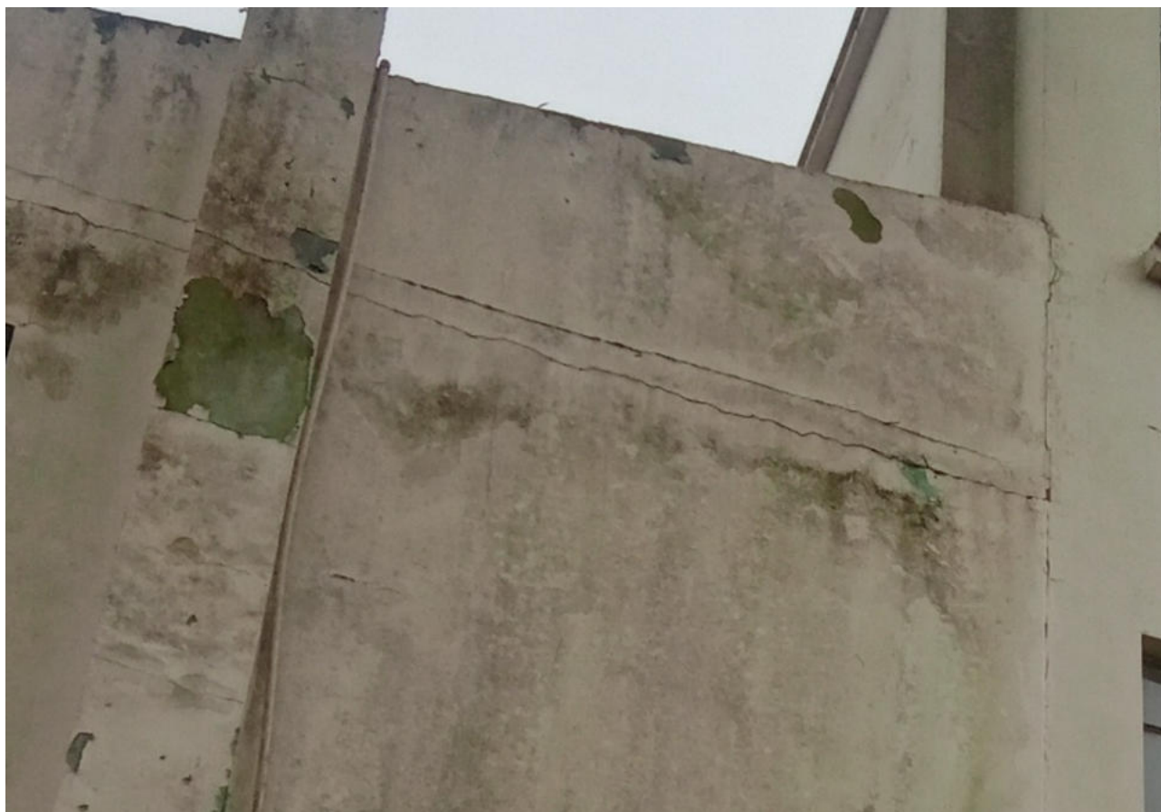
FACHADA SUL: EMASSAMENTO DE FISSURAS
