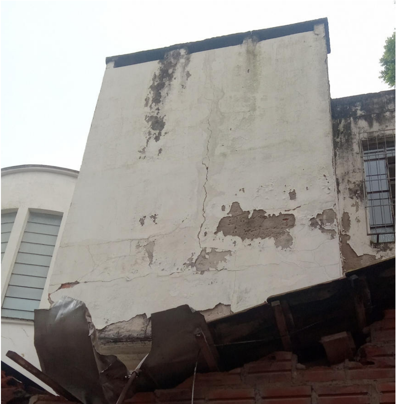
DEMOLIÇÃO DA CHURRASQUEIRA
