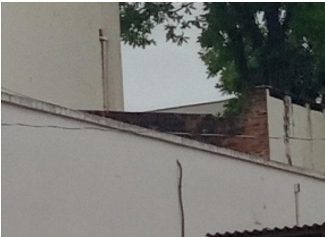
CHAPISCO E EMBOÇO ANTES DA PINTURA
