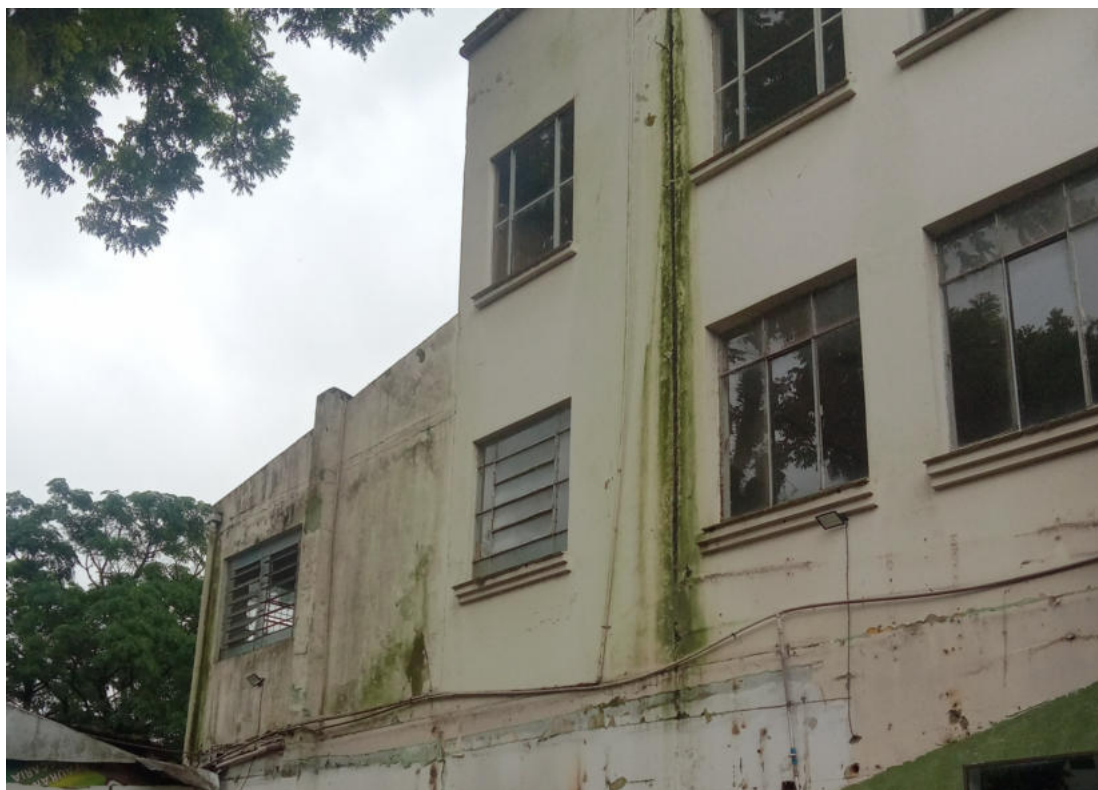
FACHADA SUL: LAVAGEM
