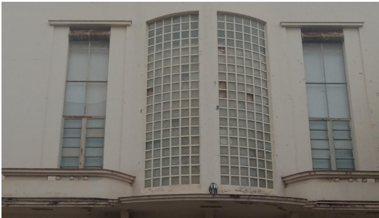
SUBSTITUIÇÃO DOS VIDROS E PINTURA
