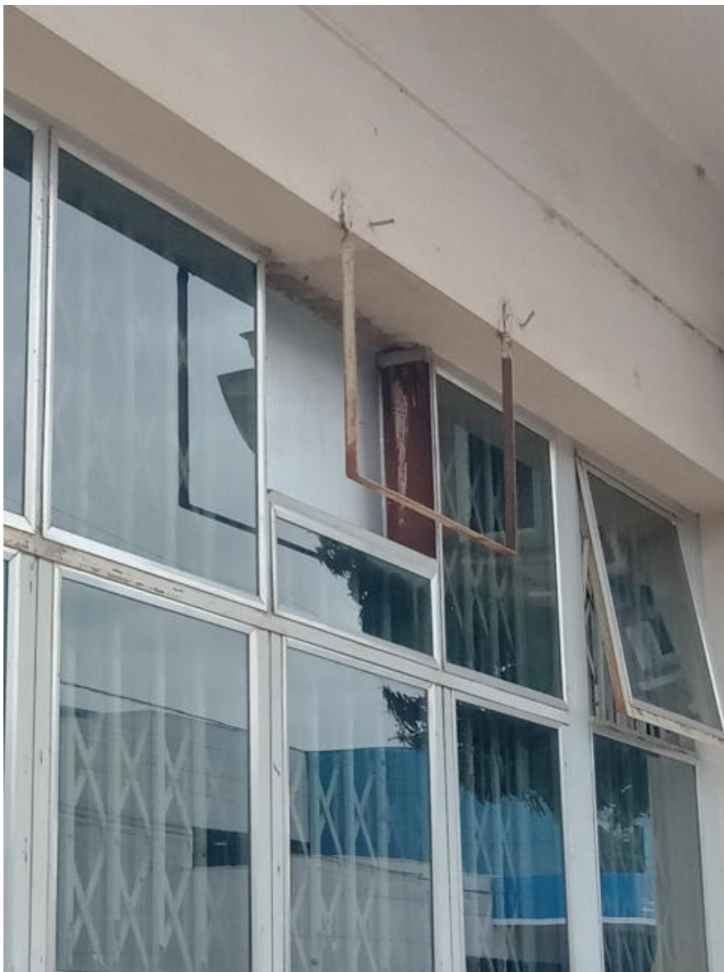
RETIRADA BARRA CHATA, SUBSTITUIÇÃO DE VIDRO E PINTURA
