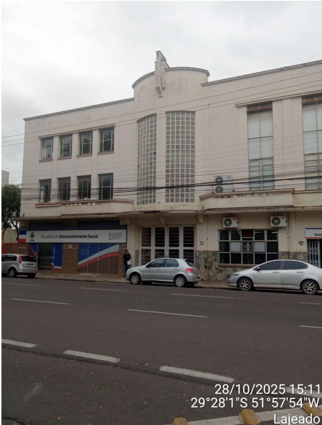
FACHADA LESTE - VISTA GERAL
