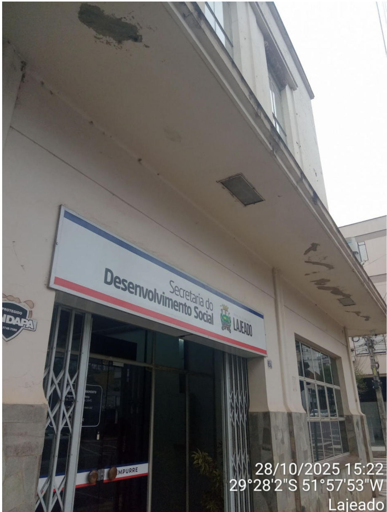
PINTURA GRADIL E REMOÇÃO DE PLACA
