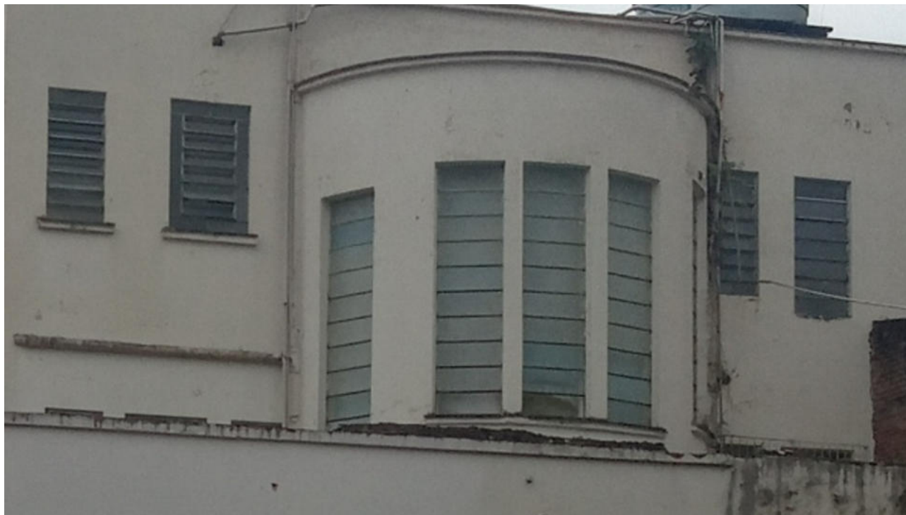
FACHADA OESTE - LIXAMENTO E PINTURA DAS ESQUADRIAS E REPOSIÇÃO DOS VIDROS
