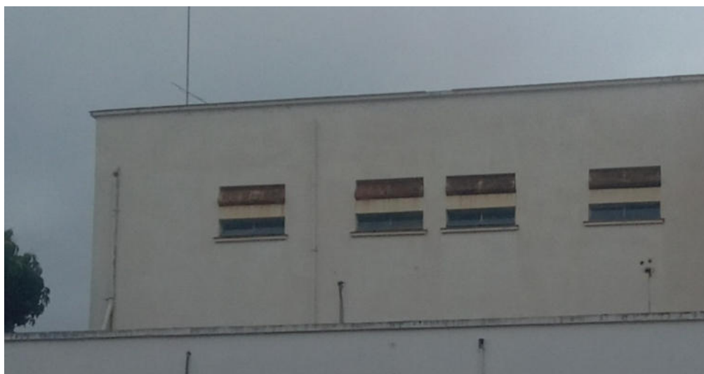
FACHADA OESTE - LIXAMENTO E PINTURA DAS ESQUADRIAS E DOS ELEMENTOS METÁLICOS
