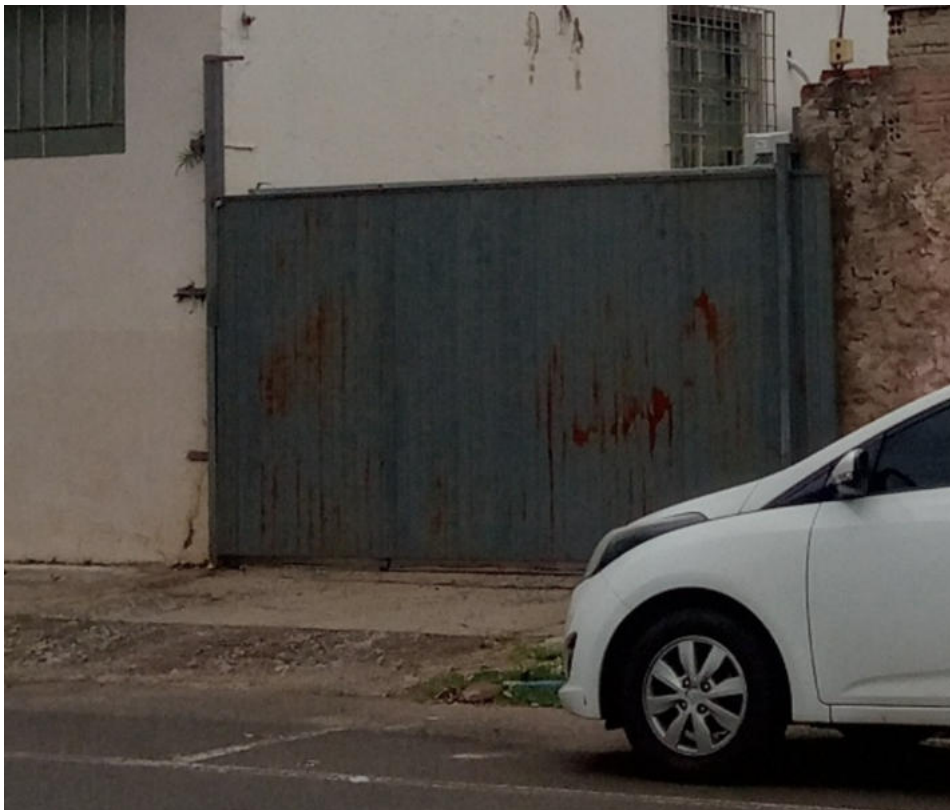
PORTÃO: LIXAMENTO E PINTURA
