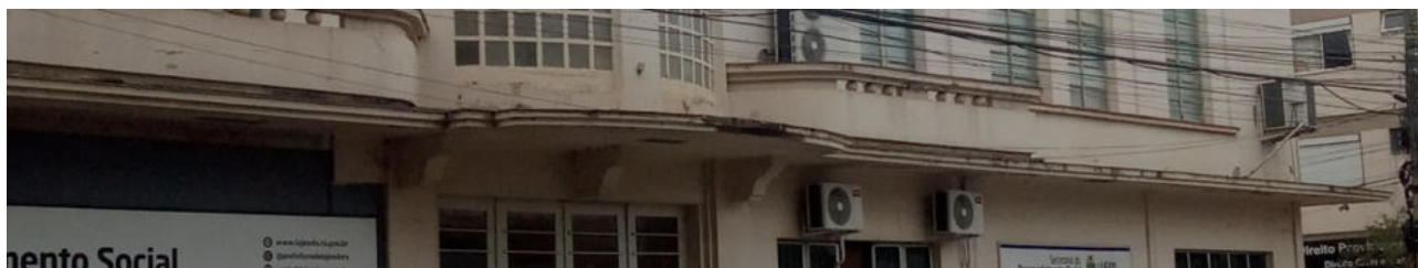
ARGAMASSA POLIMÉRICA NA MARQUISE
