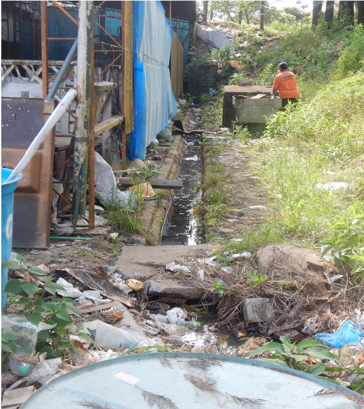
Figura 2: Lateral do pavilhão de triagem, em outubro de 2016. Fonte: SEMASS.
