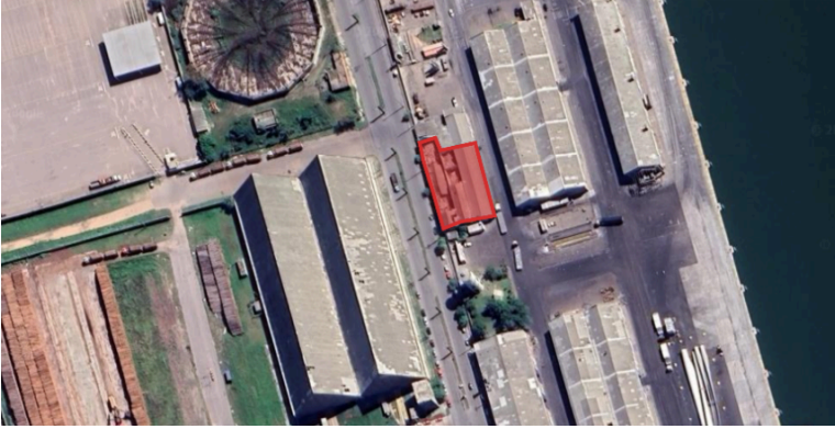
Figura 2: Vista aérea do prédio da garagem localizada no Porto Novo.
