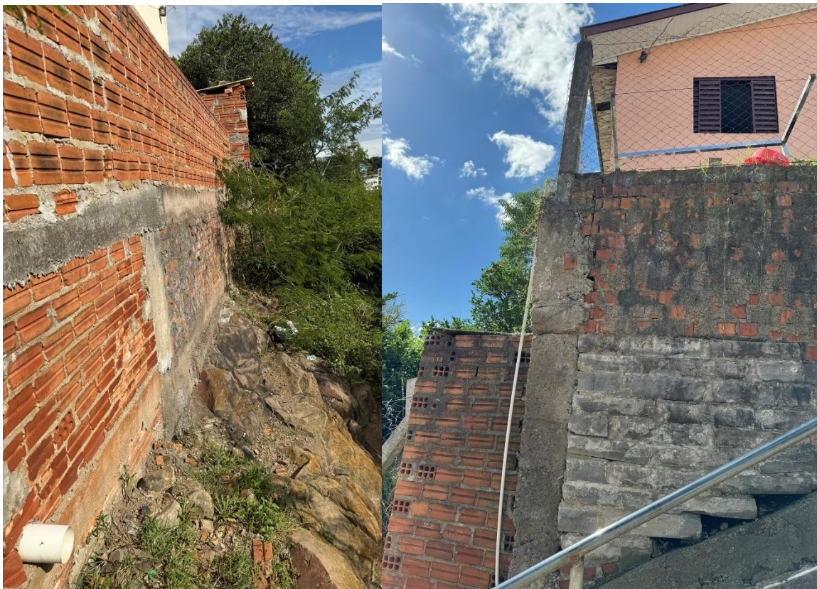
Figura 20: Muros construídos pelos moradores para vencer os desníveis do terreno
