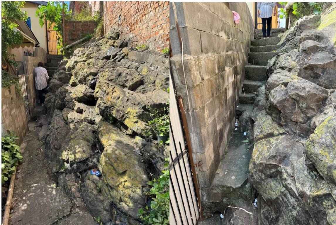
Figura 22: Casas e estruturas construídas diretamente sobre rocha aflorada
