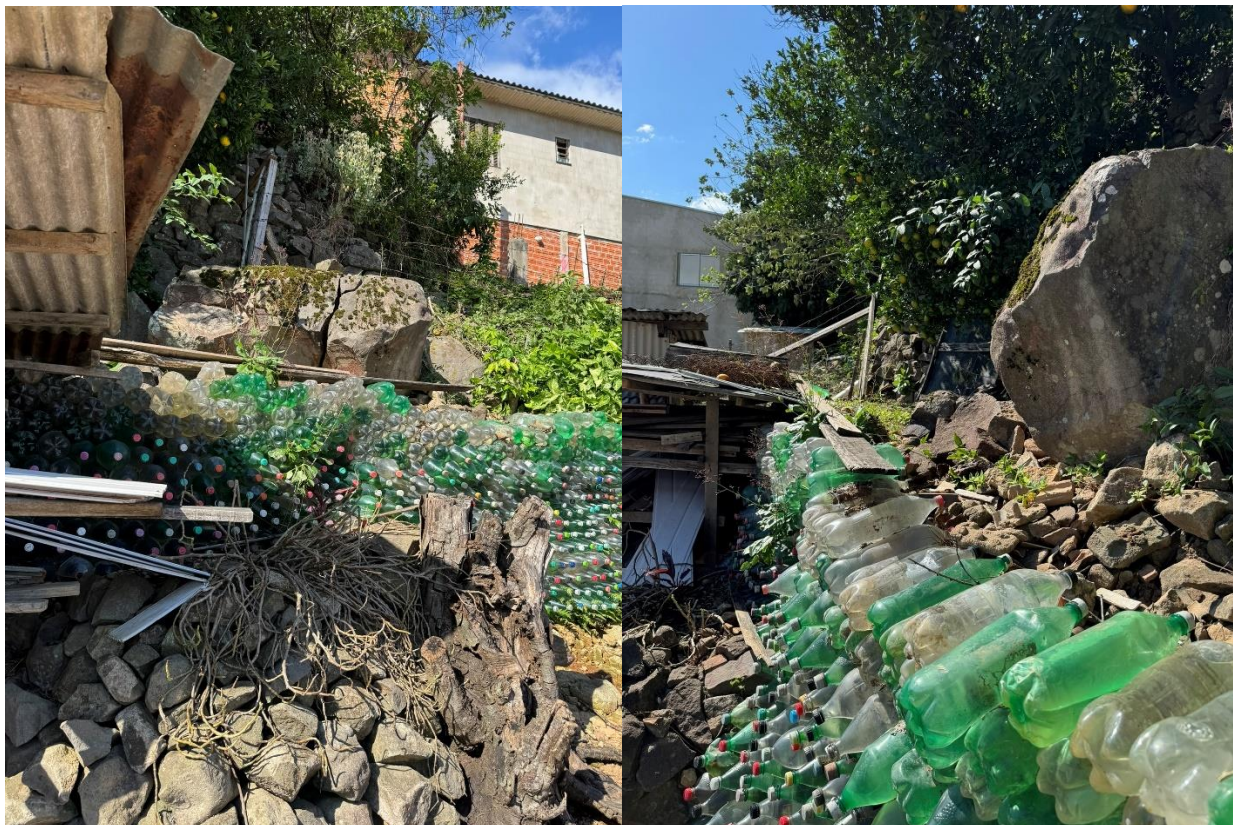
Figura 21: “Muro” de garrafas PET completamente artesanal construído pelos moradores
