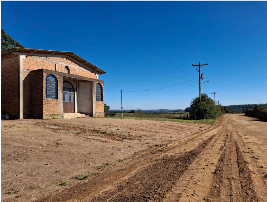
Foto 1. Visão geral da área selecionada para perfuração do poço tubular.
