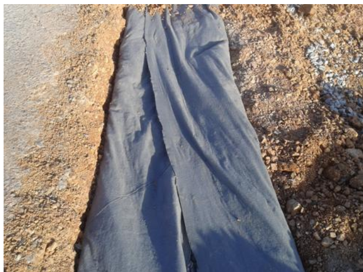
Figura 2 – Envelopamento dos tubos de drenagem e pedra britada com a manta drenante
