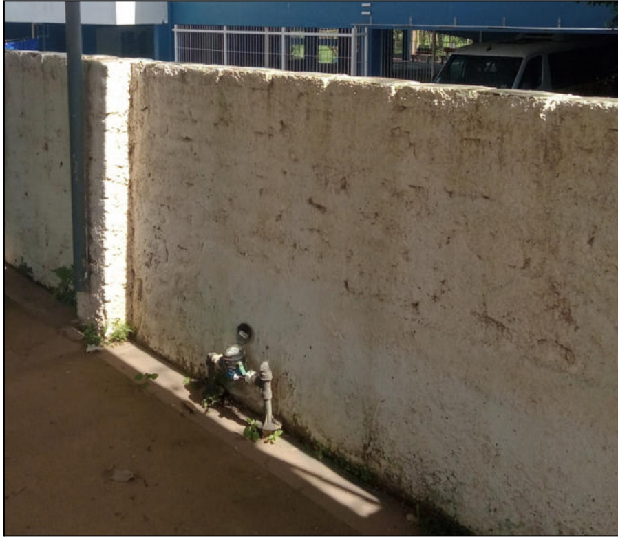
Imagem - Pintura de mureta
