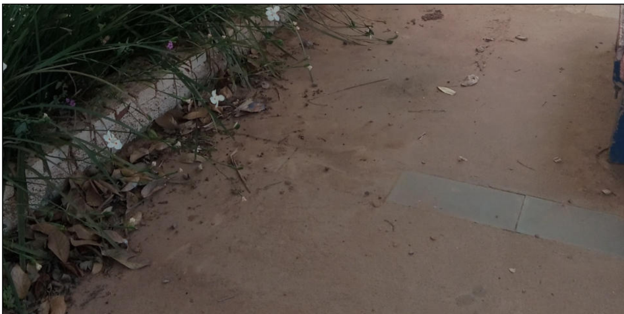
Imagem - Retirada das pedras existentes no acesso
