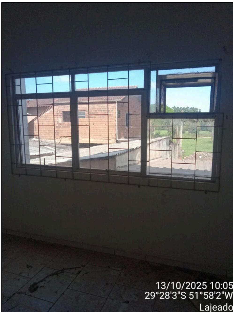
Imagem - Retirada e substituição de janela.
