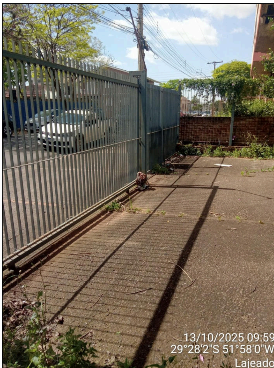
Imagem - Lixamento e pintura do portão e troca do motor
