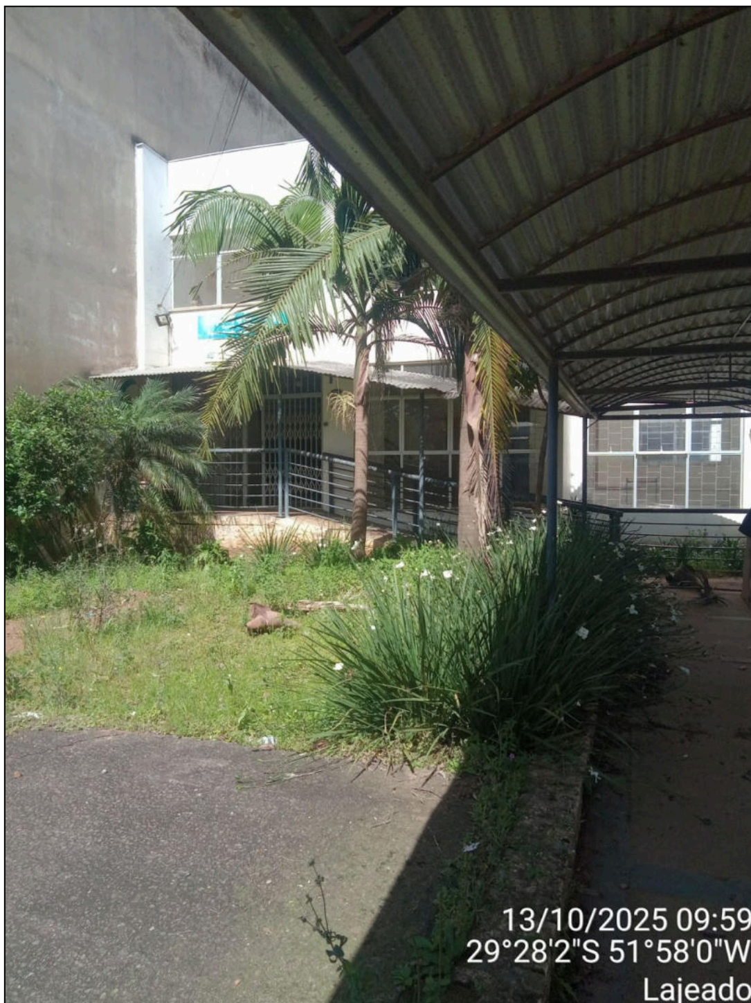
Imagem - Toldos externos a remover
