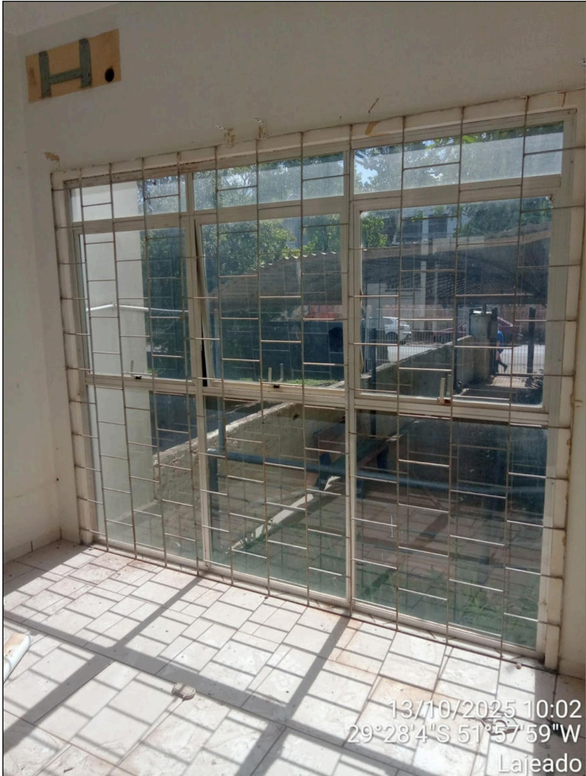
Imagem - Grades para reforma
