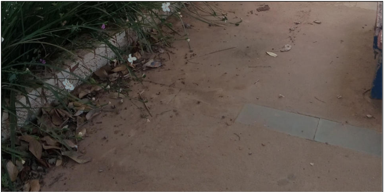
Imagem - Retirada das pedras existentes no acesso
