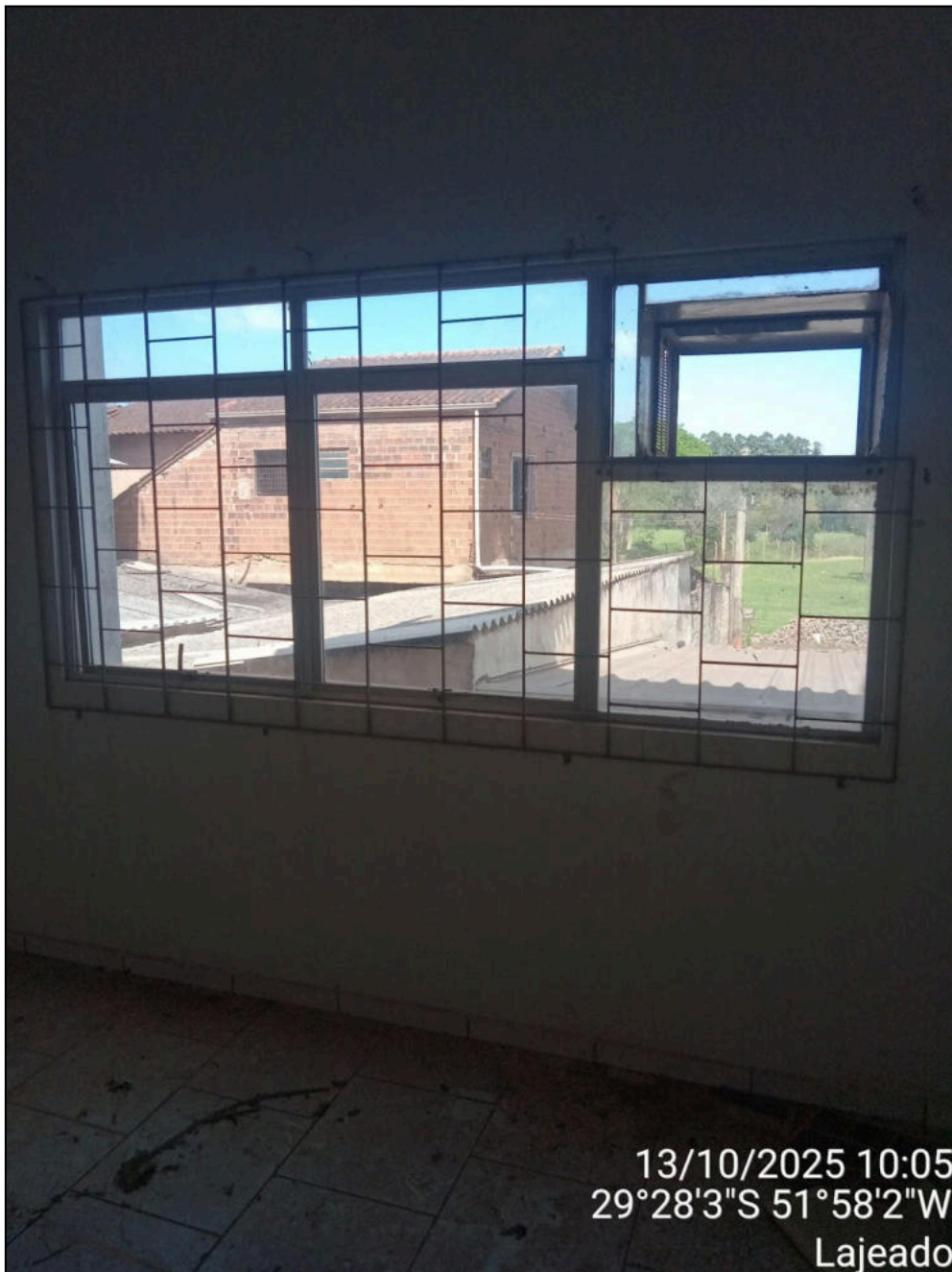
Imagem - Retirada e substituição de janela.
