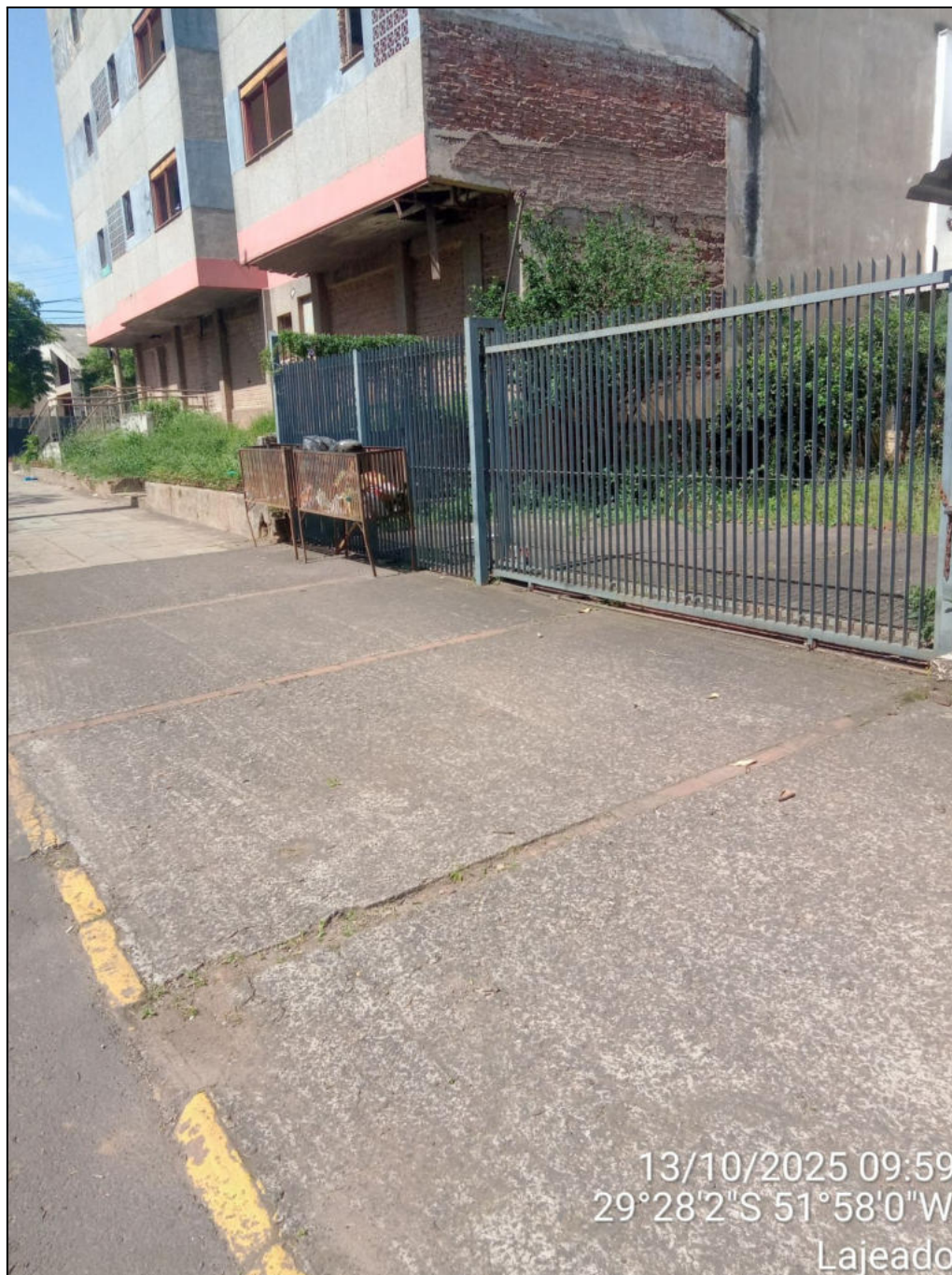
Imagem - Instalação de piso tátil
