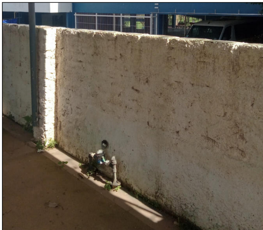
Imagem - Pintura de mureta
