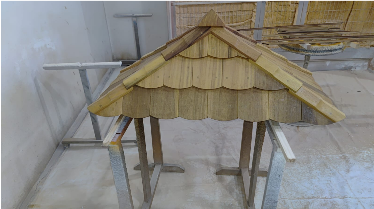
Figura 17 - Telhado em estrutura de madeira Itaúba.
