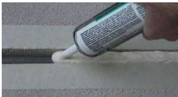
Imagem ilustrativa de aplicação e selante PU nas juntas de dilatação
