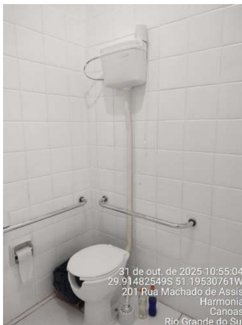
Figuras 12 e 13: Sanitário PNE com necessidade de adequação à versão atualizada da norma de acessibilidade.
