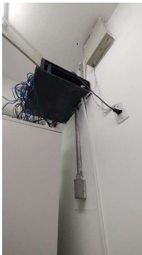
Figuras 07 e 08: Instalações elétricas e de lógica expostas e com necessidade de revisão e modernização (09.10.2025).
