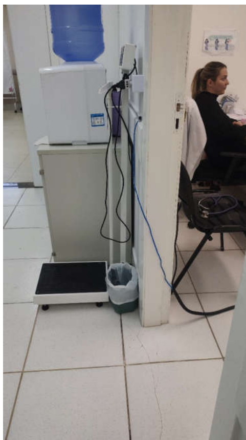
Figuras 07 e 08: Instalações elétricas e de lógica expostas e com necessidade de revisão e modernização (09.10.2025).
