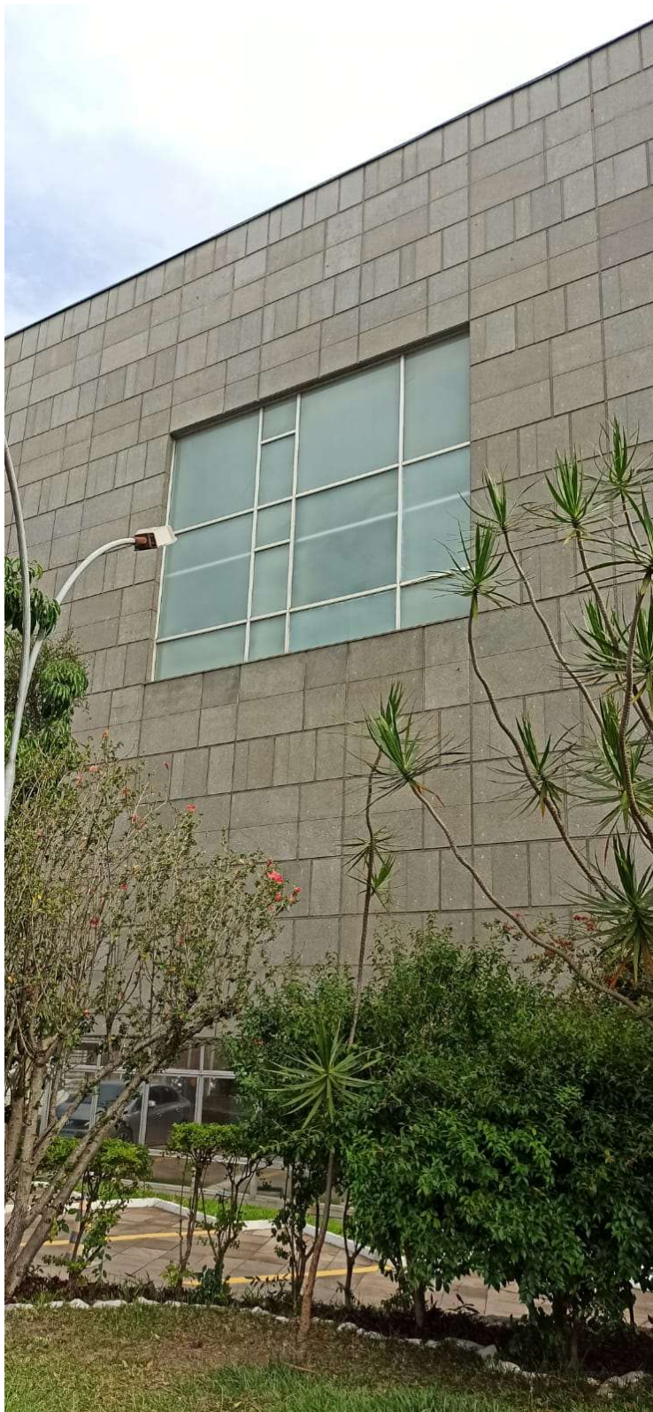
Fachada Norte – PLENÁRIO
