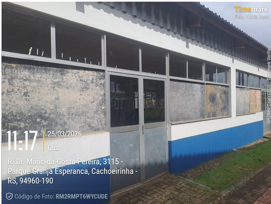
Foto 21: Fachada de prédio de utilidade pública (vestiário/bloco de serviços).
