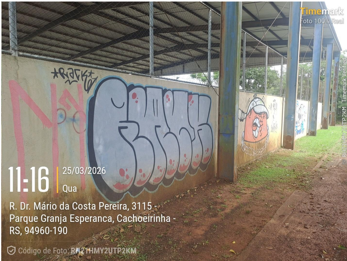
Foto 18 Muro da Quadra Poliesportiva coberta da Praça da Juventude.
