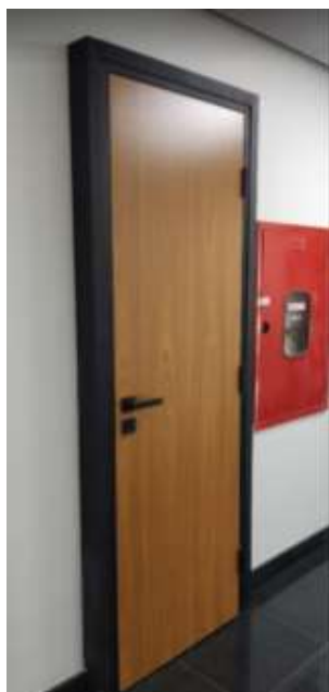
Figura 11: Porta de 60 cm utilizada nos dois shafts – PM-02
