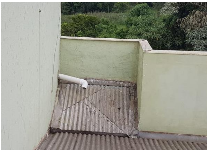
Imagem do condutor pluvial existente, o qual será conduzido até a rede de drenagem pluvial existente na edificação.
