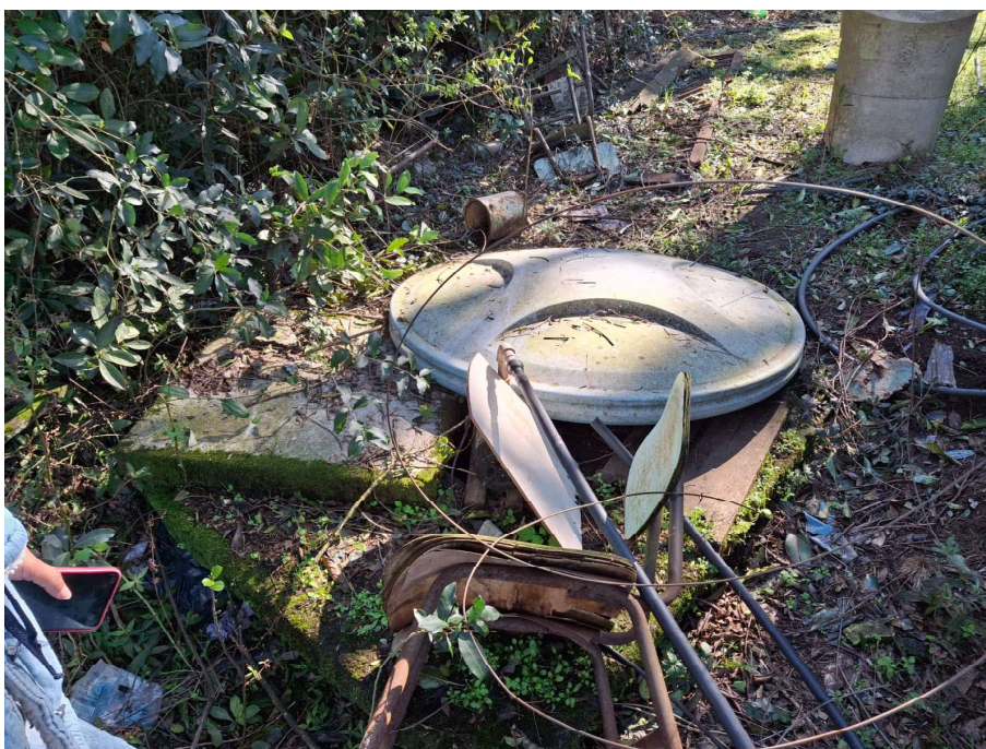
Foto 2. Captação atual em poço cacimba.
