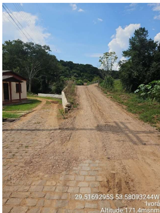
Imagem 2 – local para repavimentação com paralelepípedos e meio-fio em concreto, colocação de guarda-corpo na ala de contenção
