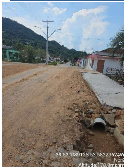
Imagem 1 –local para repavimentação com paralelepípedos e meio-fio em concreto
