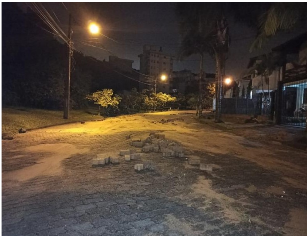
Figura 3: Enxurrada causa danos ao pavimento e propriedades particulares na Rua Davi Canabarro. Fonte: https://portalarauto.com.br/28-01-2021/fotos-e-videos-chuva-causa-alagamentos-em-santa-cruz-e-vera-cruz/
