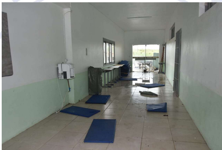
Figura 3: Vista interna da escola (registro do dia 18/02/2025)
