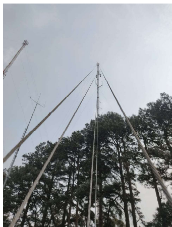
FOTO 1 Torre estaiada com 80m e 2 estabilizadores
