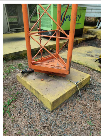
FOTO 4 Base aparente principal em boas condições
