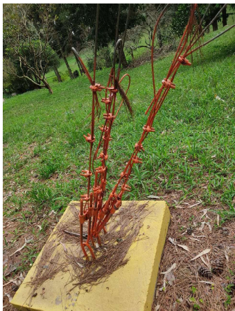
FOTO 7 Base aparente dos estais em boas condições
