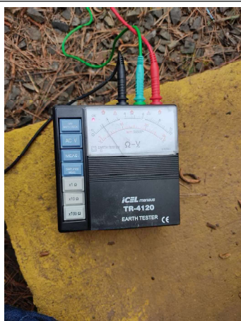
FOTO 29 Sistema de aterramento bom (1,2Ω)
