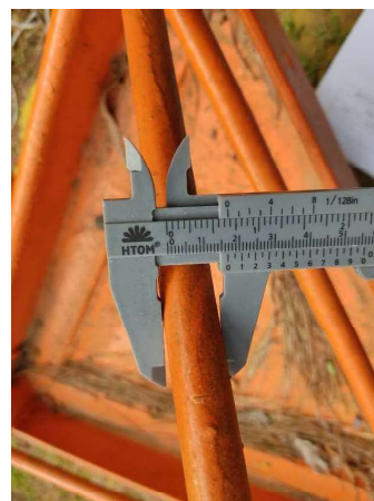
FOTO 2 Travamento ferro mecânico liso Ø16mm
