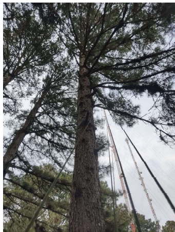
FOTO 31 Estais em meio as árvores
