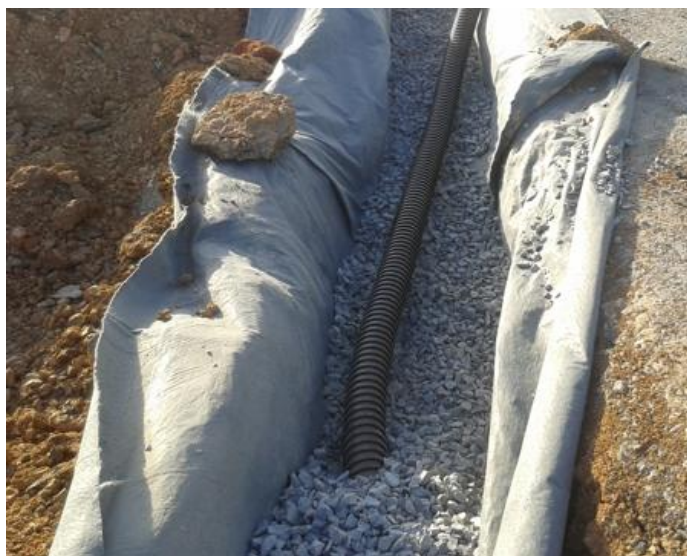
Figura 1 – Instalação de manta drenante com tudo PEAD e preenchimento em pedra britada.
