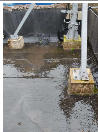
FOTO 6 Bases do mastro e estais de cantoneira
