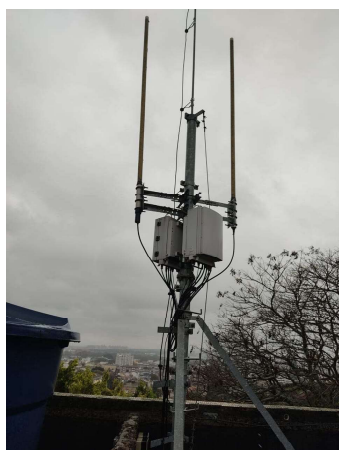
FOTO 5 Haste do para raio no topo do mastro
