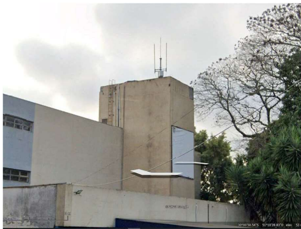
FOTO 1 Torre mastro tripé de 3m
