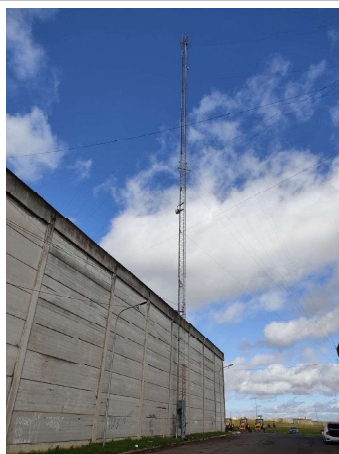
FOTO 1 Torre estaiada com 60m e 2 estabilizadores
