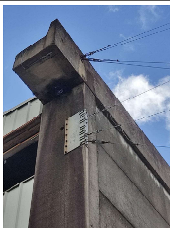
FOTO 3 Ancoragem dos estais
