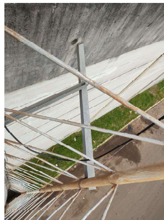
FOTO 26 Ancoragem da torre em viga de concreto
