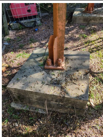
FOTO 27 Base da torre
