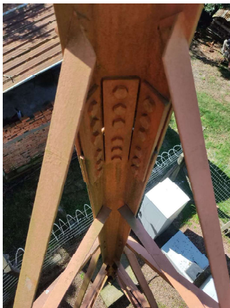
FOTO 19 Conexões dos montantes da estrutura
