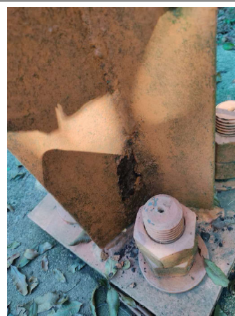
FOTO 24 Base da torre
