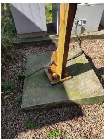
FOTO 23 Base da torre
