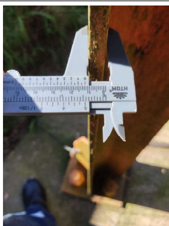
FOTO 29 Montante da base
