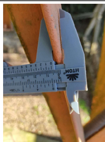
FOTO 28 Travamentos da base
