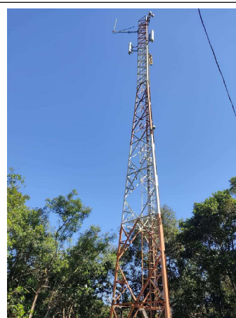
FOTO 30 Estrutura da torre
