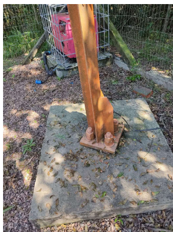
FOTO 25 Base da torre
