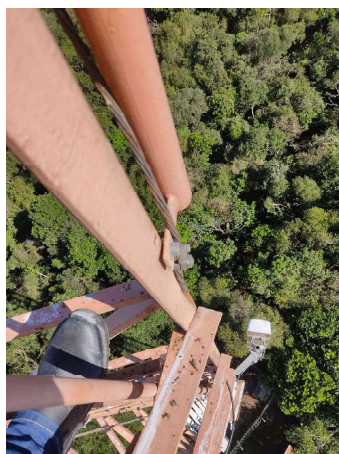
FOTO 13 Cabeamento do para raio
