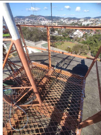
FOTO 22 Plataforma da base da torre
