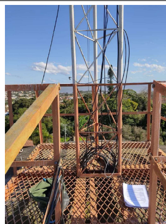
FOTO 30 Base da torre
