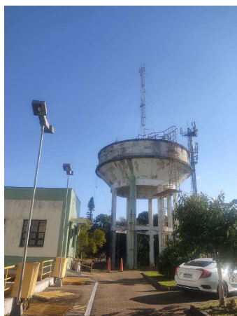
FOTO 1 Torre estaiada de 12m + Cx D'Água de 11,8m
