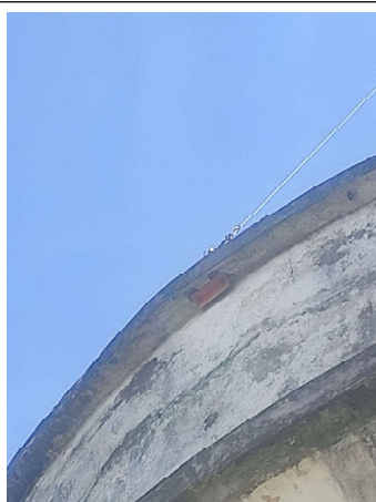
FOTO 5 Fixação do estai na caixa d'água
