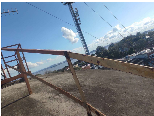
FOTO 11 Passarela de acesso a plataforma
