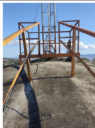
FOTO 12 Plataforma na base da torre
