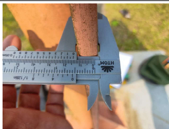
FOTO 28 Montante da base – chapa 1/2"
