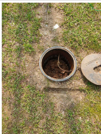
FOTO 11 Aterramento – Ponto de medição
