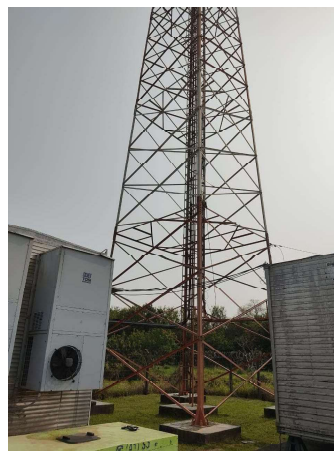
FOTO 2 Estrutura da torre
