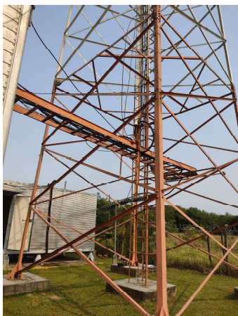
FOTO 3 Bases da torre
