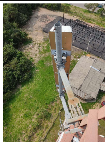
FOTO 24 Antena painel celular
