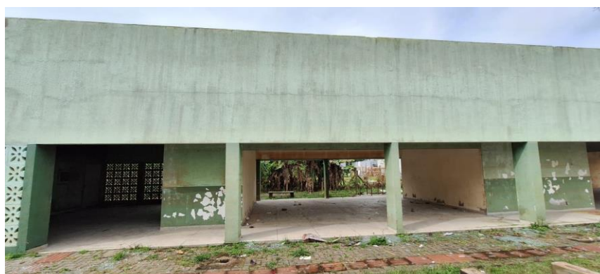
Foto 05- Bloco 01- instalações do canteiro de obras
