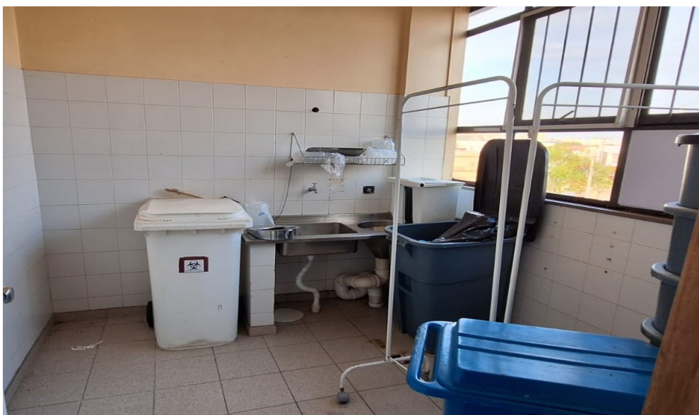
Figura 16: Área de expurgo.
