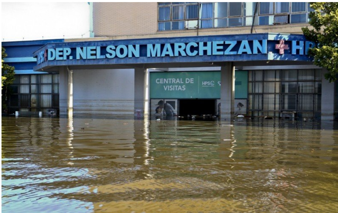
Figura 4: Imagem do acesso principal do HPSC durante a enchente de maio de 2024.
